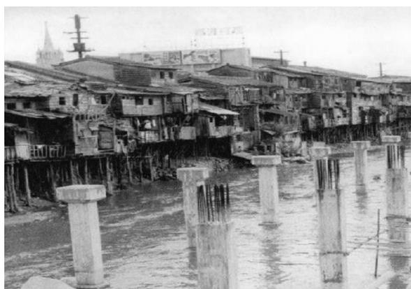
*Figura 11: Início da construção das lajes para o tamponamento do córrego. Fonte: Reis et al (2016,p.119)*
