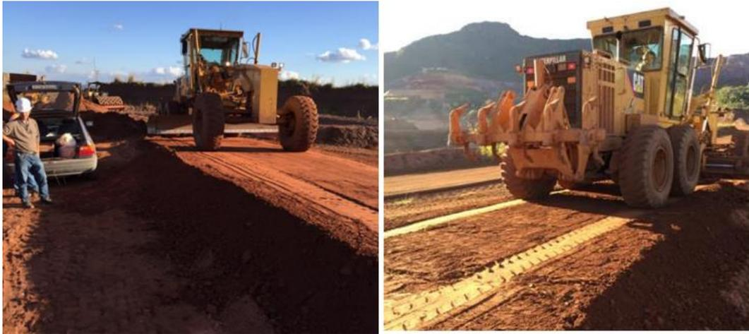
Figura 34: Espalhamento do rejeito e preparação do aterro experimental. A imagem da esquerda encontra-se uma motoniveladora e na imagem a direita um trator de pneu do tipo pá carregadeira equipada com grades em sua parte traseira.
