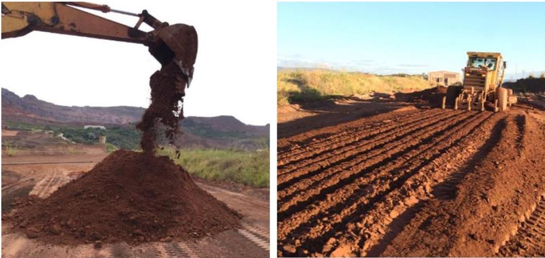
Figura 33: Imagem a esquerda: Retirada do rejeito do *sump*. Imagem a direita: Espalhamento e homogeneização de camadas no aterro experimental.
