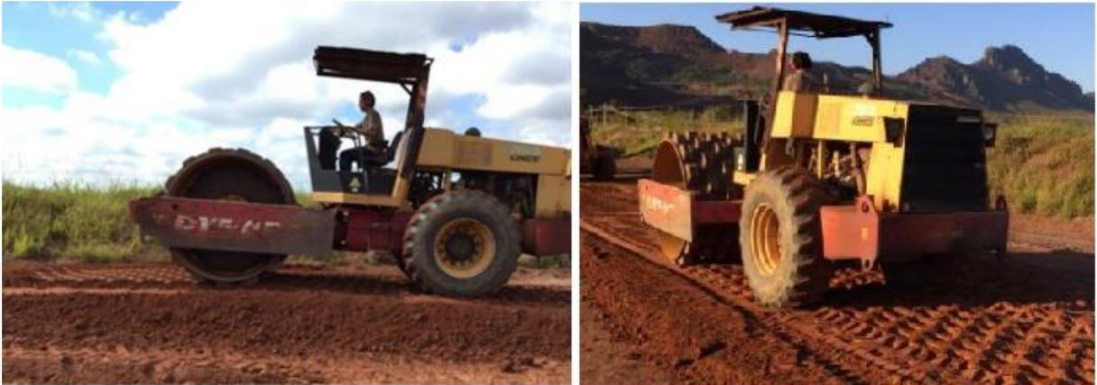
Figura 35: Compactação do aterro experimental com rolo compactador pé-de-carneiro.
