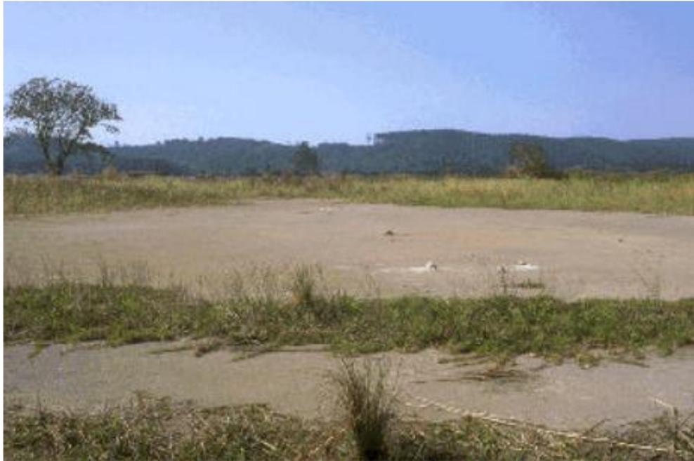
Figura 6: Cava resultante do processo de extração de argila, parcialmente preenchida com material estéril e posteriormente completada com solo superficial e areia por meio de aterro hidráulico.
