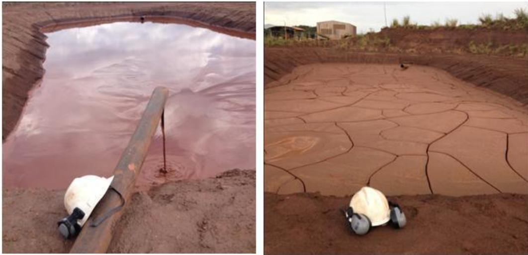
Figura 32: Imagem a esquerda: Lançamento da polpa de rejeito no *sump*. Imagem da direita: Vista do processo de secagem natural do rejeito por evaporação, drenagem superficial e percolação pela fundação.
