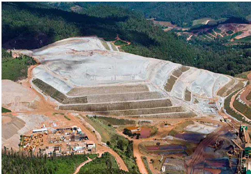
Figura 4: Estrutura de empilhamento drenado.
