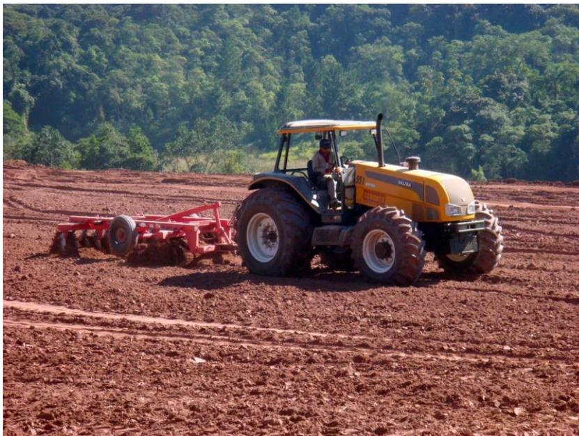
Figura 18: Trator agrícola de pneu com grade, também conhecido como “*girico*”, realizando a escarificação de um solo para recebimento da próxima camada de compactação.
