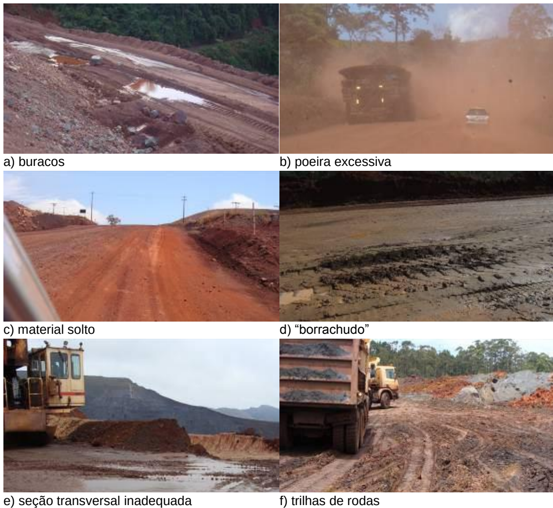
Figura 11 - Defeitos comuns em estradas de mina
