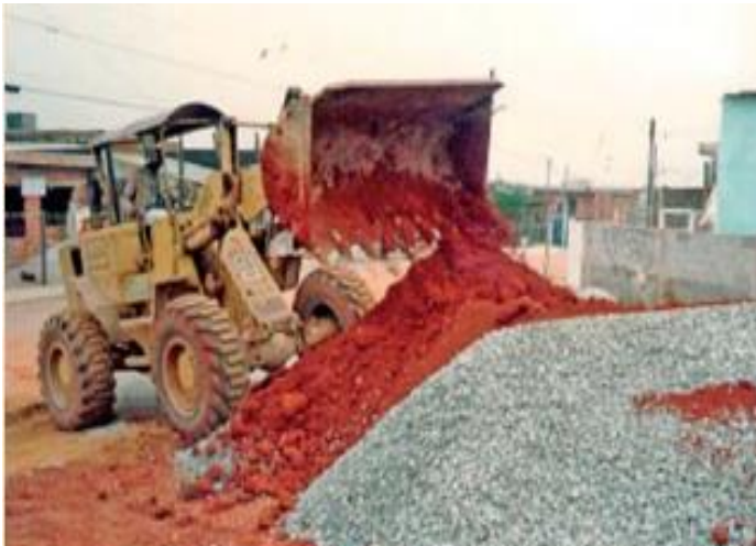
(a) Solo-brita descontínuo: mistura em pista
