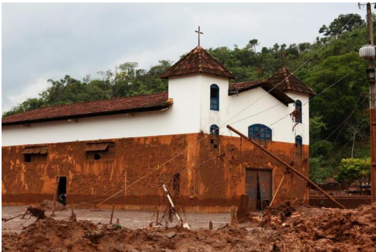
Figura 29 - Capela de Santo Antônio, localizada no subdistrito de Paracatu de Baixo, após a passagem do mar de lama da barragem de Fundão, em 2015.
