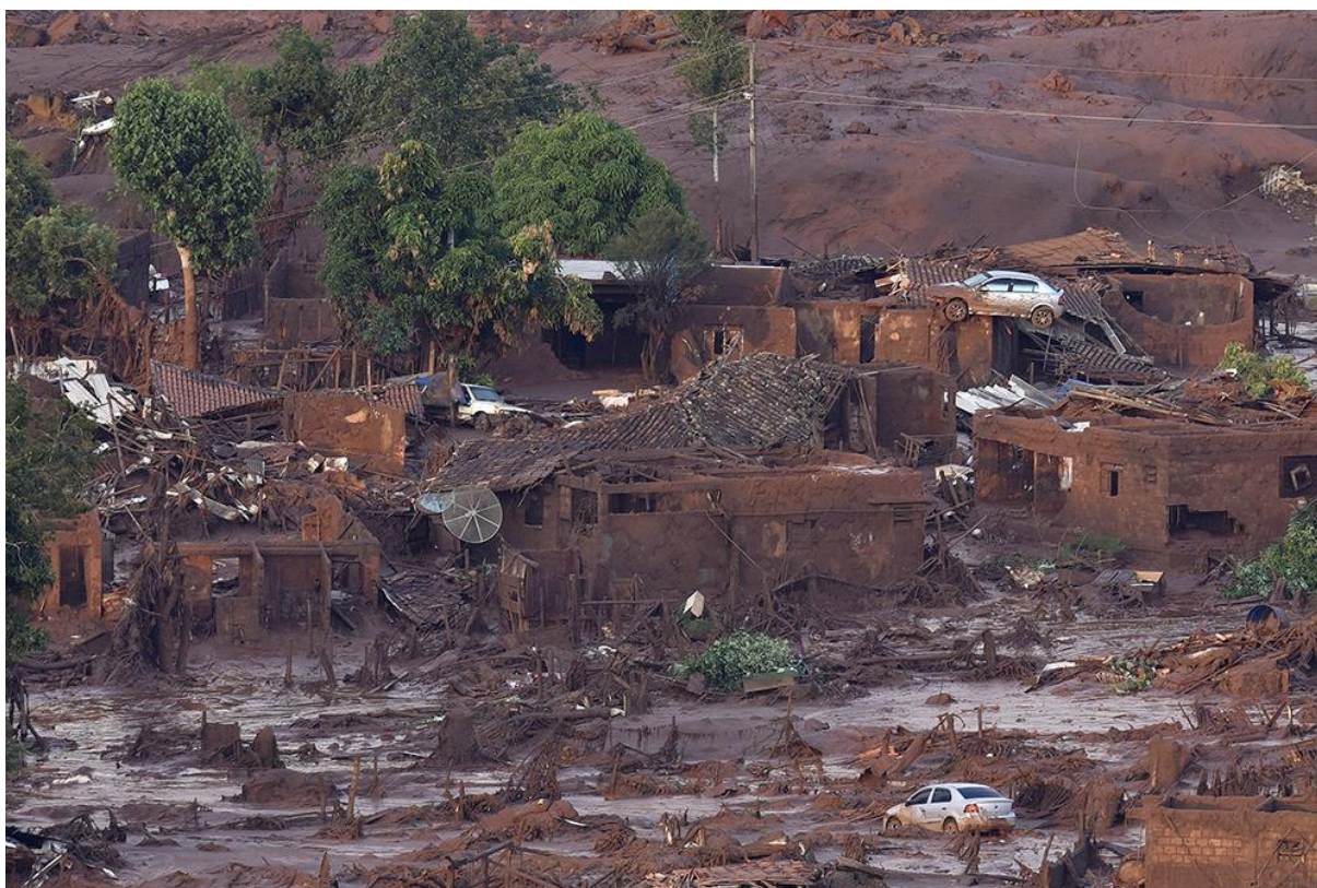
Figura 35 - Registro da situação das casas de Bento Rodrigues logo após o rompimento da barragem de Fundão.
