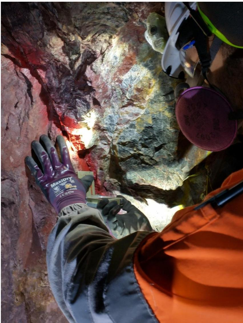
*Figura 5 - Uso da bússola para coleta de atitudes das estruturas no Mapeamento Geomecânico da Mina Vazante*
