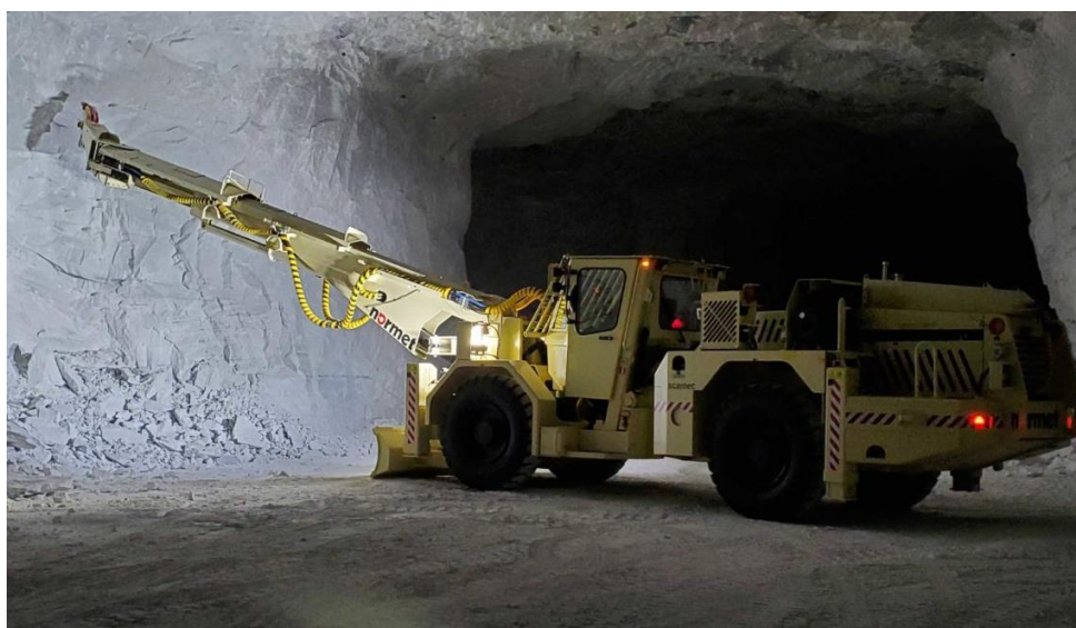
Figura 7 – Equipamento tipo Scaler em operação
