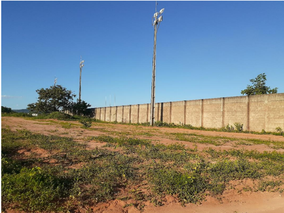
Figura 41: fachada leste vista da Av. Leão XIII
