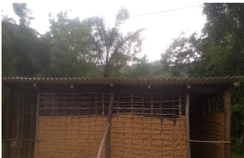
Figura 6 - Foto da sede Congado, em construção coletiva, feita de pau-a-pique, realizada durante o ano de 2020 - foto: Sérgio Chará.
