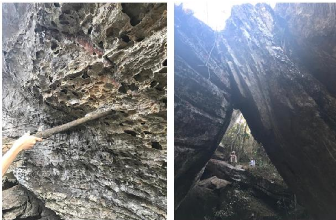
Figura 4.7 - A (Esquerda): intensa erosão alveolar apresentando alvéolos com até 10 centímetros de profundidade; B (Direita): blocos soltos apoiados em paredes externas. Fonte: acervo pessoal.
