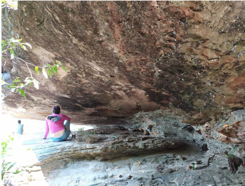
Figura 4.8 - Extenso nível erodido com alteração ferruginosa. Fonte: acervo pessoal.
