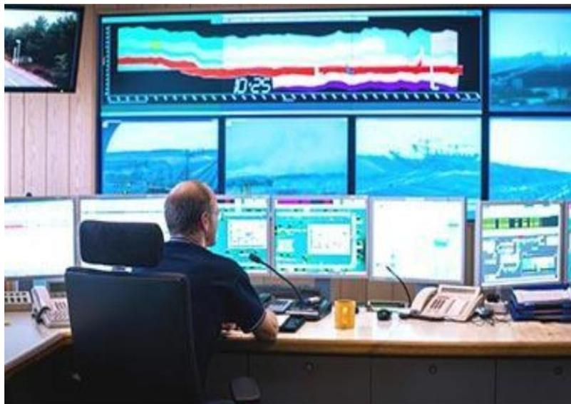
Figura 10 - Monitores mostrando parâmetros da rede de ventilação em tempo real (ABB, 2019).
