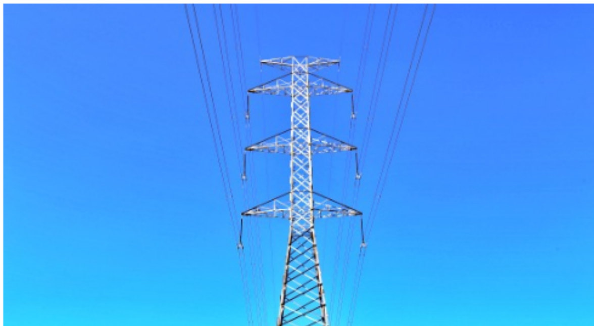
Figura 3 – Torre de Transmissão
