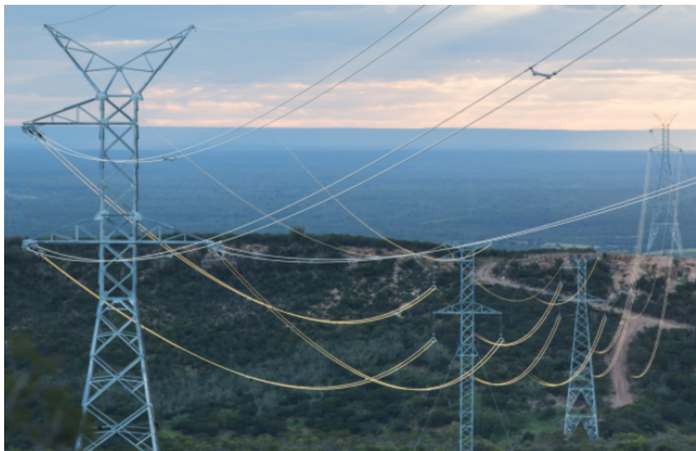
Figura 15 – Torre de transmissão
