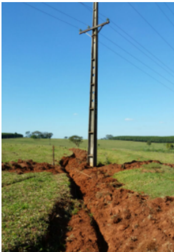
Figura 18 – Instalação de eletrodos na horizontal
