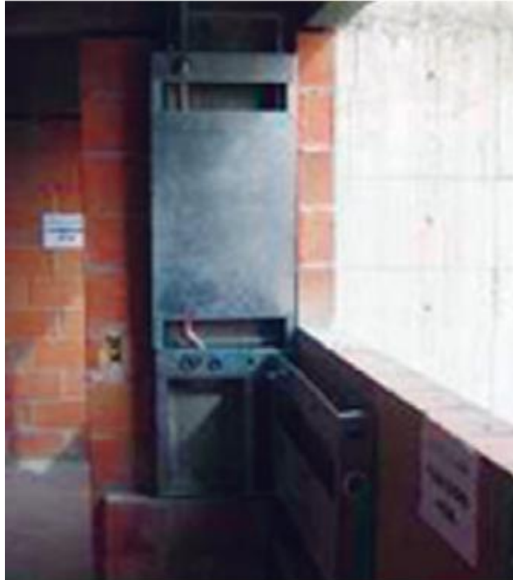
Figura 5.6: “Carenagem metálica para ocultar tubulações, minimizando recortes” (Fonte: Manual de Resíduos, Sinduscon-SP, 2015)
