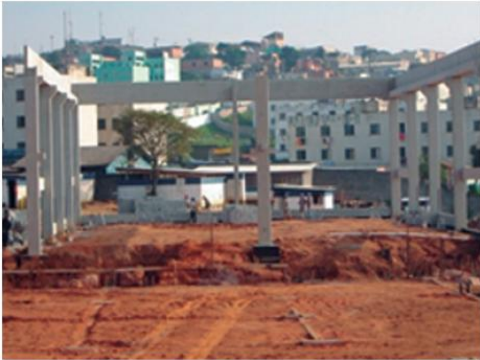
Figura 5.1: “Estrutura em concreto pré-moldado” (Fonte: Manual de Resíduos, Sinduscon-SP, 2015)
