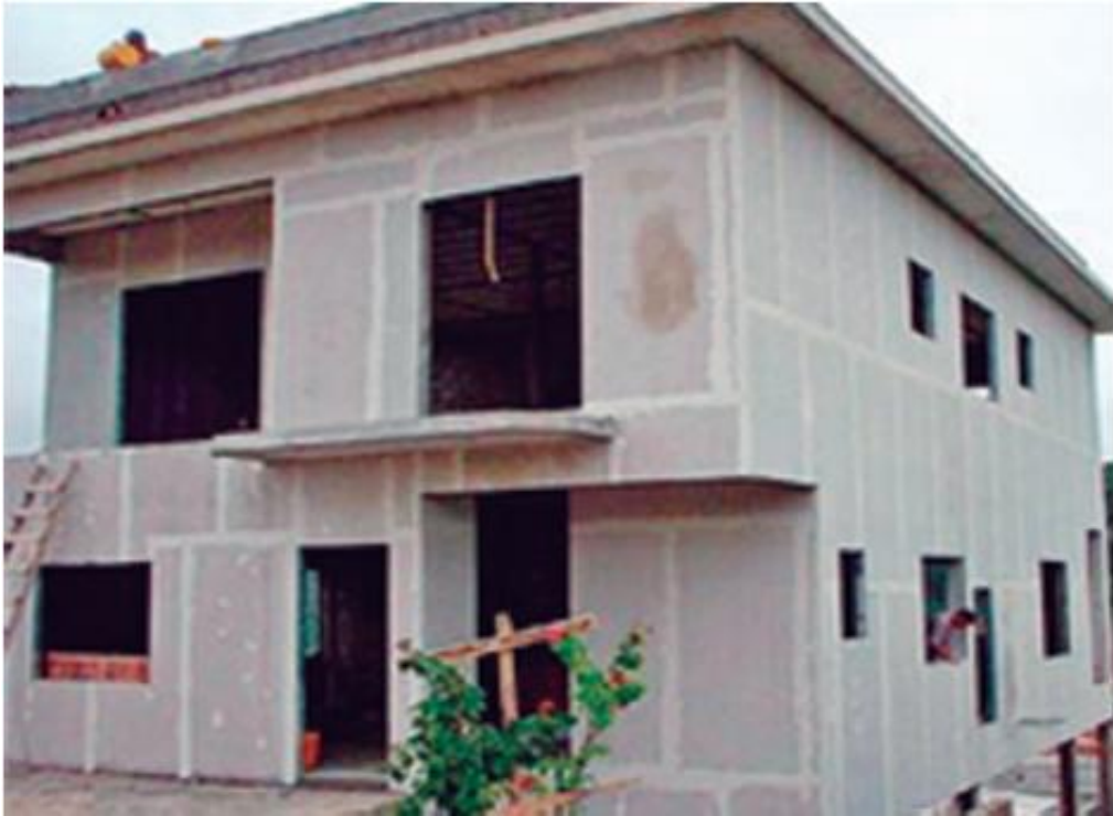
Figura 5.4: “Paredes externas de casa com uso de placa cimentícia” (Fonte: Manual de Resíduos, Sinduscon-SP, 2015)
