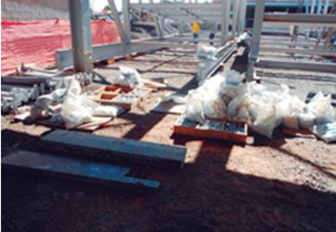
Figura 6.13: “Uso de espaço na projeção do edifício para estoque intermediário de componentes miúdos em caixas e sacos”
