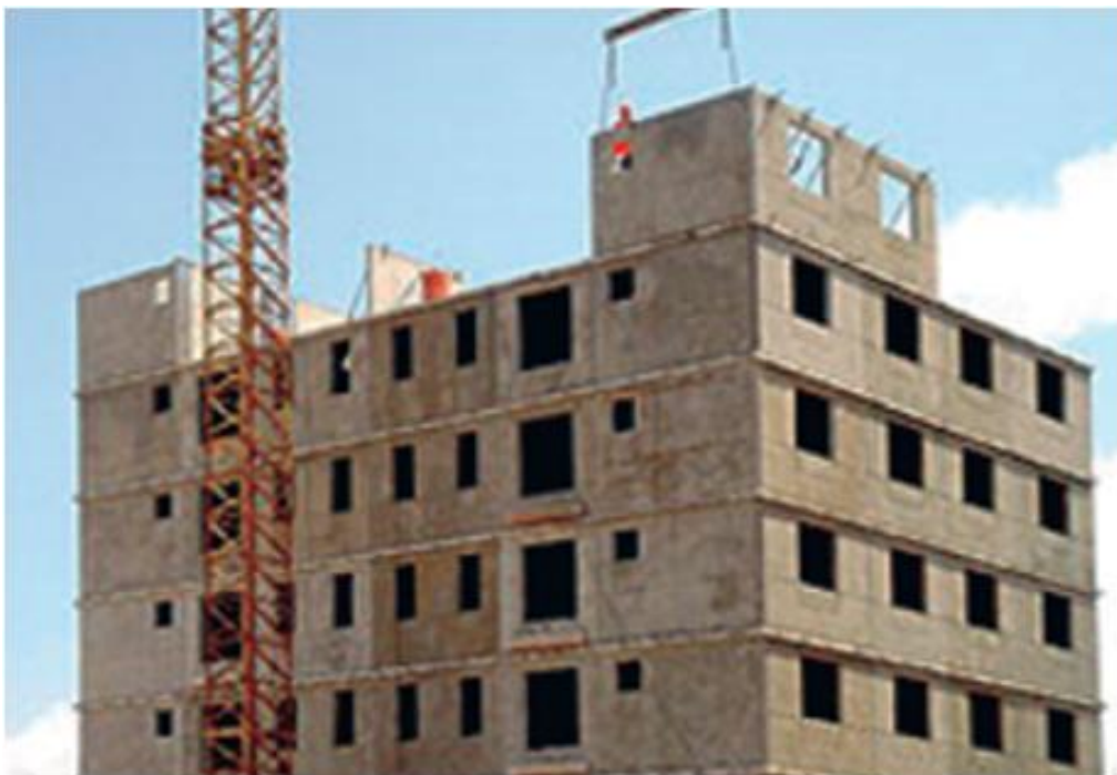
Figura 5.2: “Elevação e montagem com uso de grua de pré-moldados como elemento estrutural e de vedação” (Fonte: Manual de Resíduos, Sinduscon-SP, 2015)
