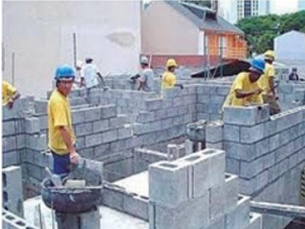
Figura 5.3: “Execução de paredes em alvenaria estrutural com blocos de concreto” (Fonte: Manual de Resíduos, Sinduscon-SP, 2015)
