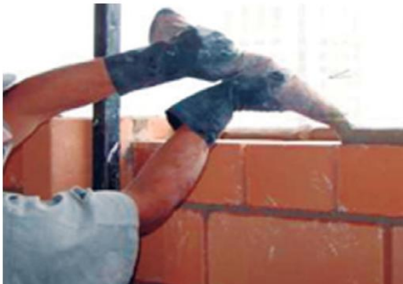
Figura 5.8: “Uso de bisnaga dosadora em assentamento de blocos para vedação”
