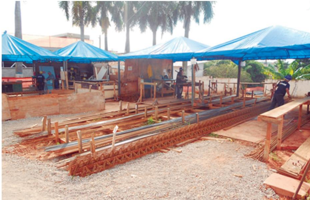
Figura 5.10: “Feixes com vergalhões e armaduras” (Fonte: Manual de Resíduos, Sinduscon-SP, 2015)
