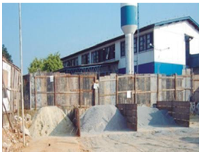
Figura 5.9: “Estoque agregados a granel em baias” (Fonte: Manual de Resíduos, Sinduscon-SP, 2015)
