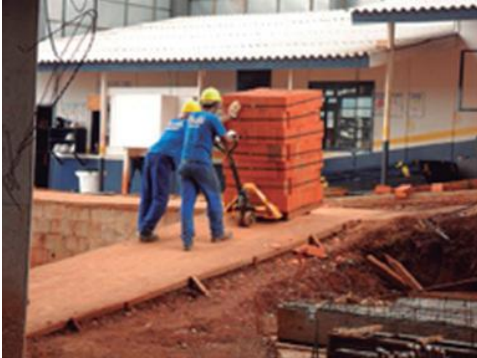
Figura 5.11: “Uso de carrinho porta-paletes no transporte de blocos cerâmicos” (Fonte: Manual de Resíduos, Sinduscon-SP, 2015)
