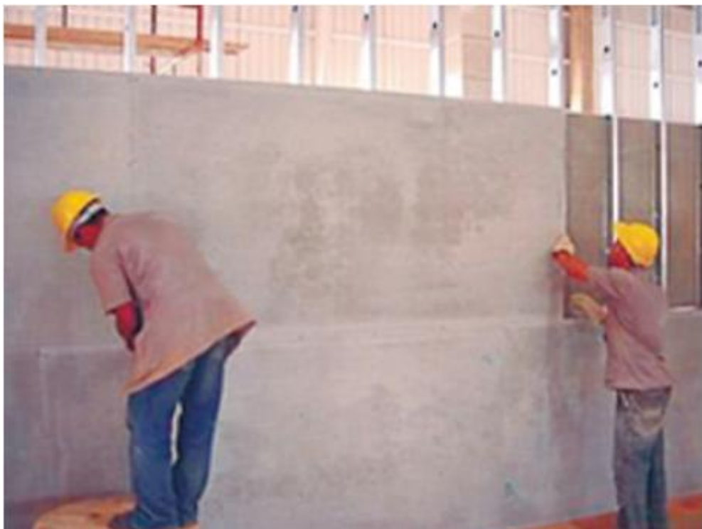
Figura 5.5: “Montantes de placas em drywall para vedações internas” (Fonte: Manual de Resíduos, Sinduscon-SP, 2015)
