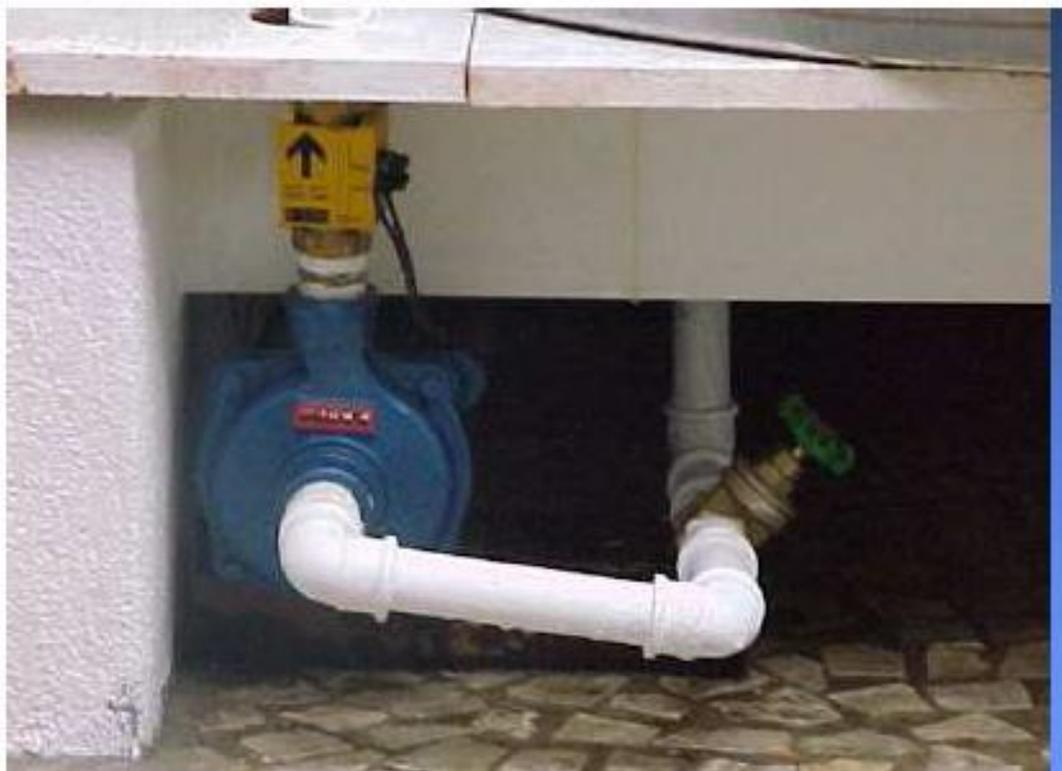
Figura 12: Bomba centrífuga
