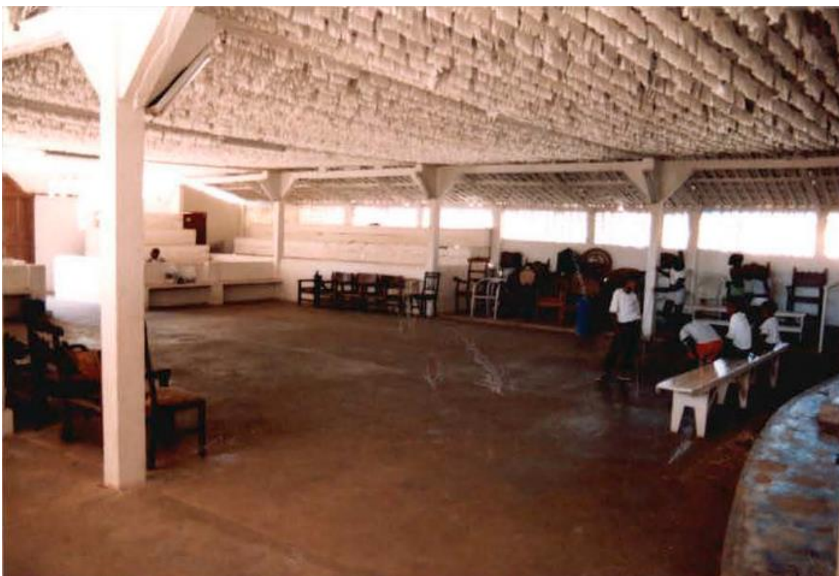
Imagem 32 — Vista parcial do interior do barracão de festas
