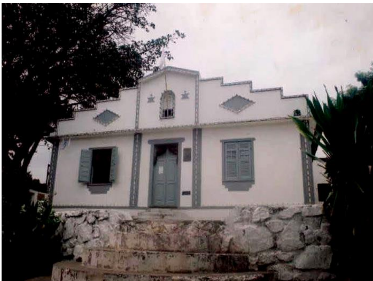
Imagem 17 — Fachada frontal do templo principal do terreiro de Gantois
