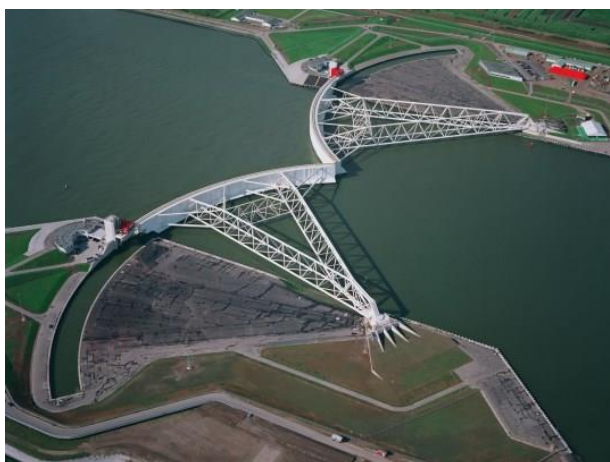
Figura 8 Barreira Maeslant Fechada
