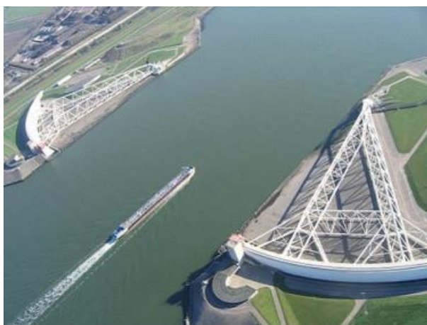
Figura 7 Barreira Maeslant Aberta
