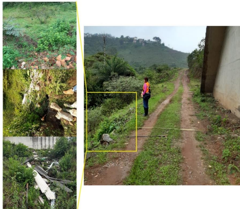
Figura 5.13 - Lixo jogado na base da ETE por moradores locais a fim de impedir o processo de erosão acelerado. Fonte: acervo pessoal.
