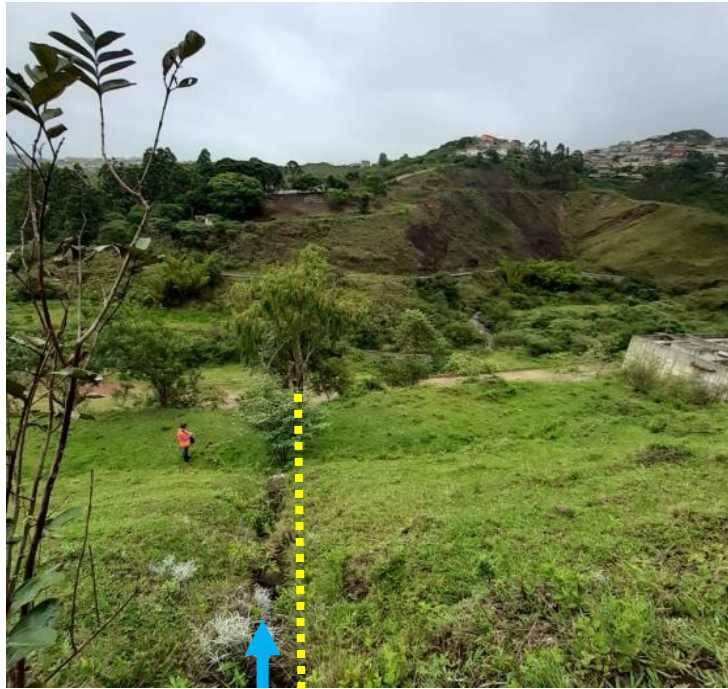
Figura 5.12 - Ravina de aproximadamente 15 metros de comprimento. Pontilhado amarelo indica lateral da ravina e seta azul indica o sentido do fluxo d'água. Fonte: Acervo pessoal.
