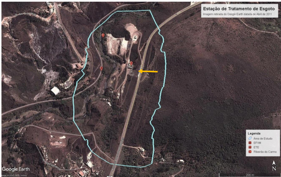
Figura 5.17 - Imagem satélite de 2011 retirada do Google Earth durante a construção da ETE. Seta indica talude onde ocorreu o escorregamento.
