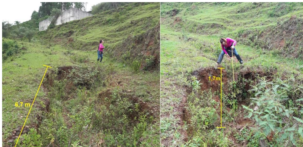
Figura 5.11 - Processo de voçorocamento na área abaixo da ETE. Fonte: acervo pessoal.
