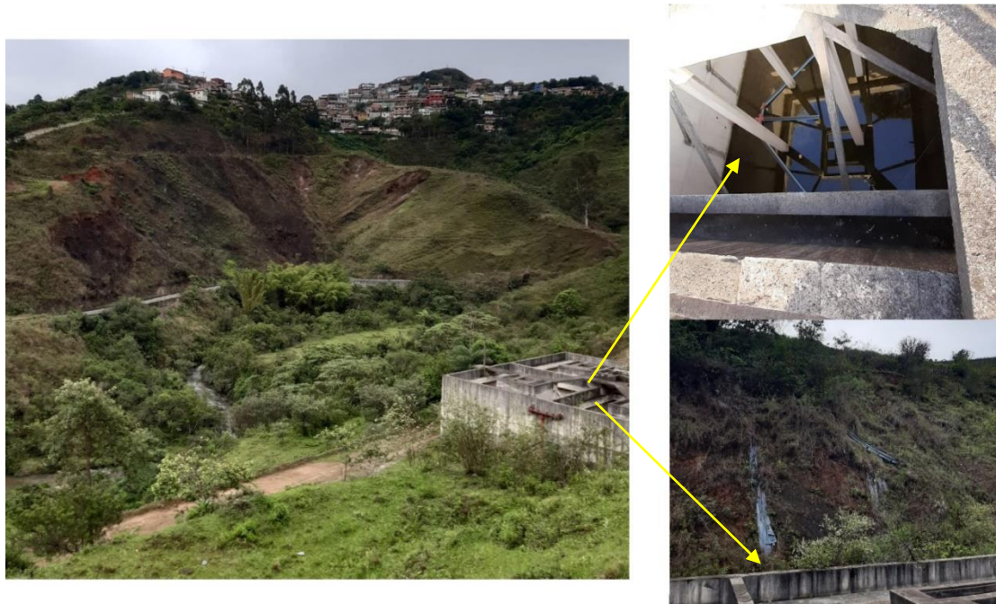
Figura 5.14 - Situação de abandono da estrutura, com água parada e lonas de contenção removidas pelos movimentos gravitacionais de massa. Fonte: acervo pessoal.
