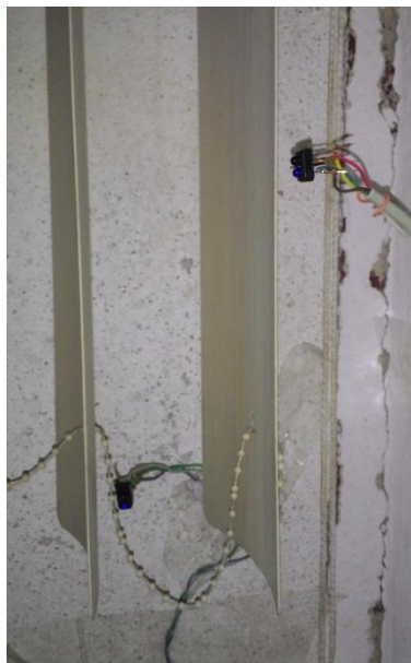
Figura 3.9: Sensores opticos instalados
