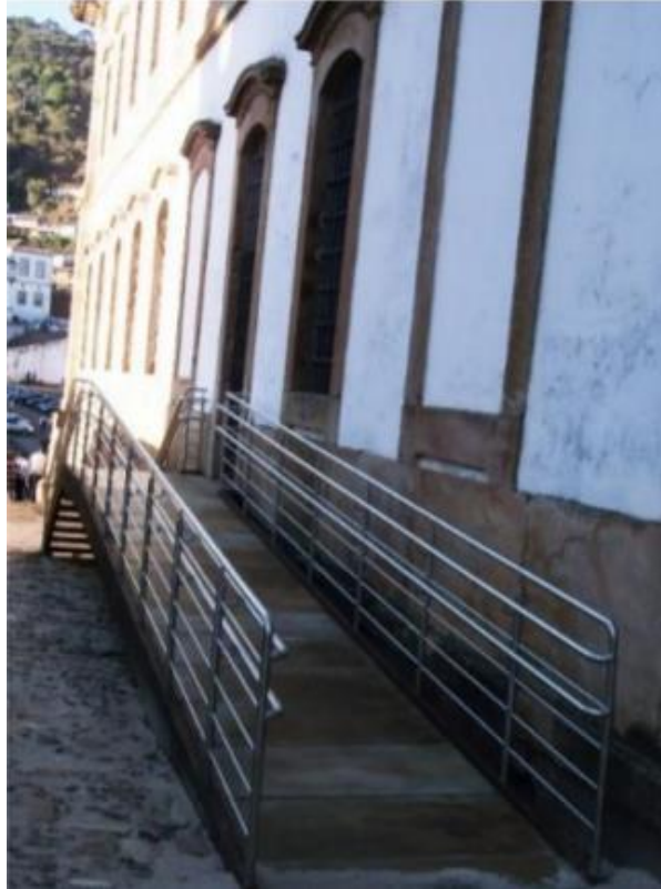
Figura 8: Rampa de acesso ao Museu da Inconfidência (Antiga Câmara)
