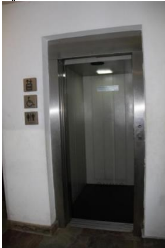
Figura 9: Elevador no Museu da Inconfidência
