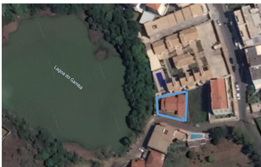
Figura 35: Vista aérea da edificação estudada (destacada no quadro azul) e da sua vizinhança. Fonte: Google Earth 2020.
