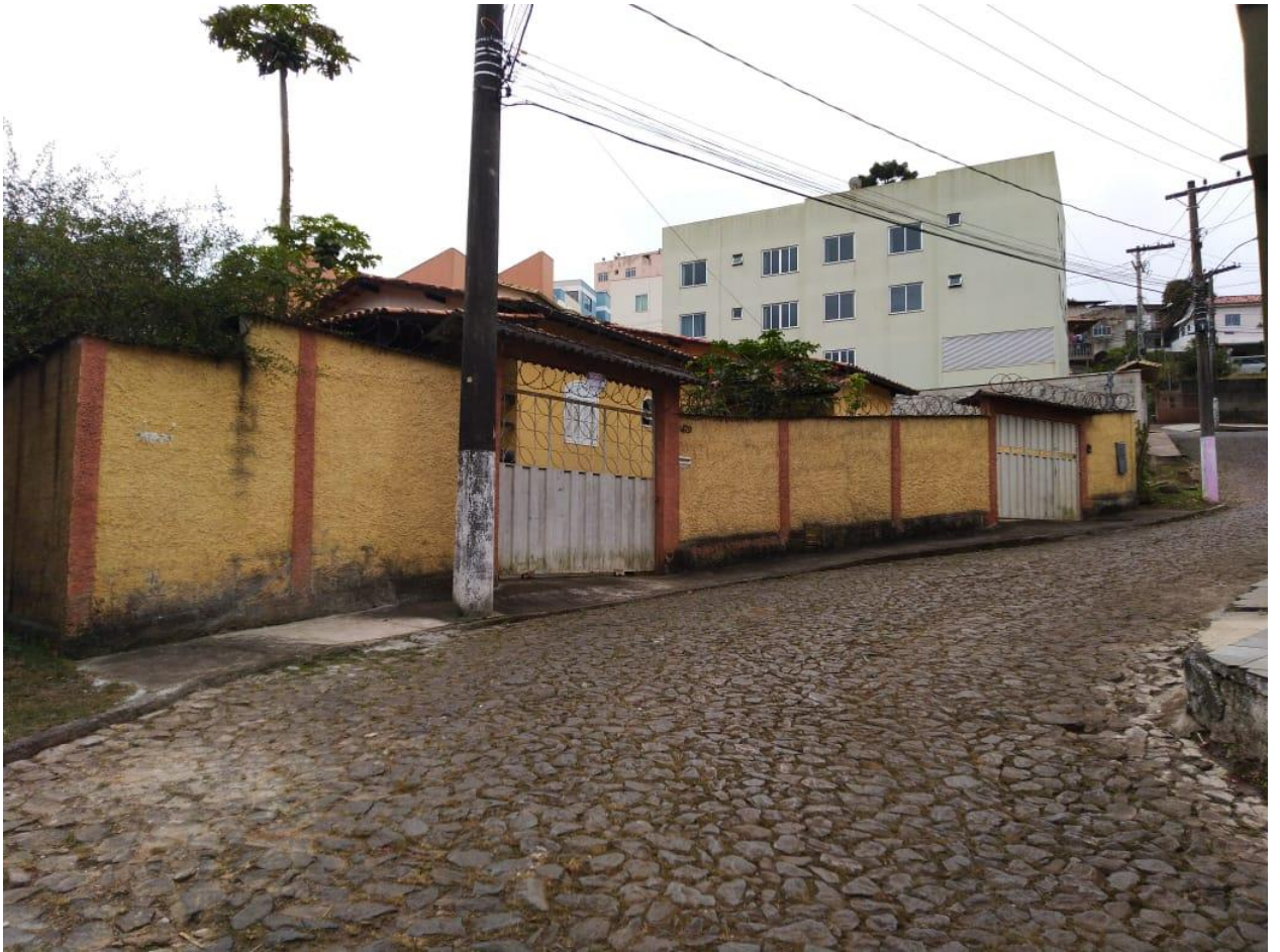
Figura 5: Vista frontal do imóvel analisado no estudo de caso. Fonte: autor.
