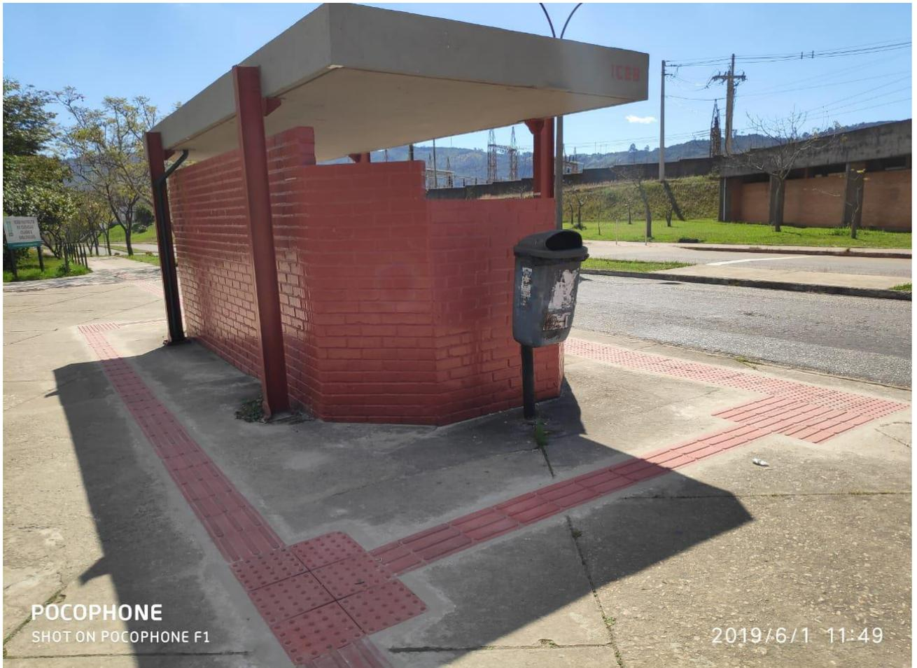
*Figura 38 - Pisos táteis nos pontos de ônibus - ICEB*
