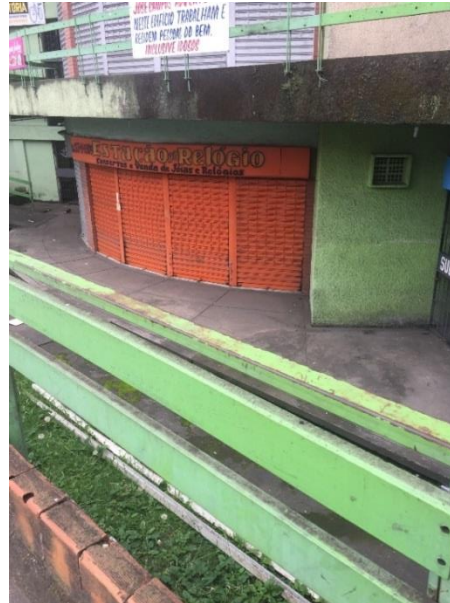
Figura 38 - Subsolo do Edifício Redondo
