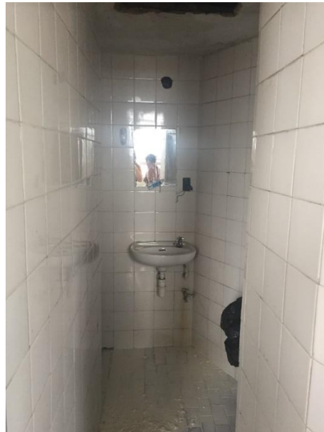
Figura 41 - Banheiro de um dos apartamentos
