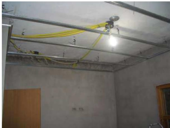
Figura 6 - Instalações elétricas executadas em cima do forro
