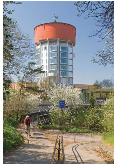
Figura 16 - Jægersborg Water Tower antes da intervenção
