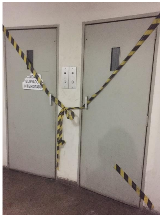
Figura 39 - Elevadores Interditados por falta de manutenção
