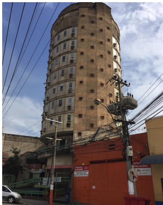
Figura 49 - Vista lateral do edifício redondo
