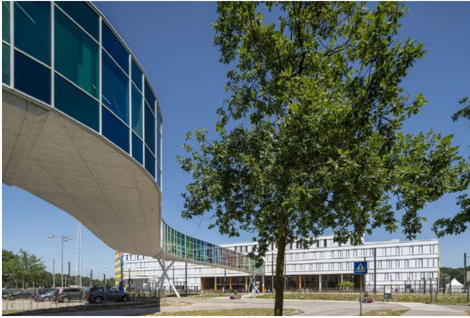
Figura 18 - Vista externa da ponte. Fonte: https://www.archdaily.com.br/br/912899/centro-de-oncologia-infantil-princess-maxima-liag-architects .
