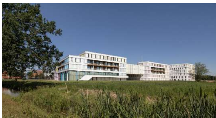
Figura 14 - Fachada do Centro Oncológico Princess Maxima. Fonte: https://www.archdaily.com.br/br/912899/centro-de-oncologia-infantil-princess-maxima-liag-architects .
