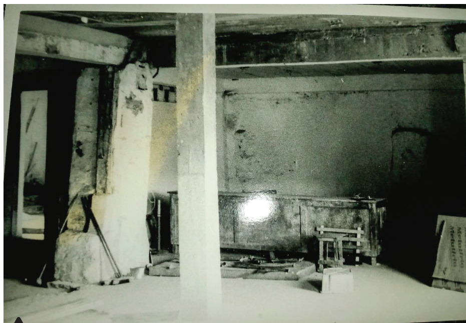
Espaço da antiga padaria - antes da reforma
