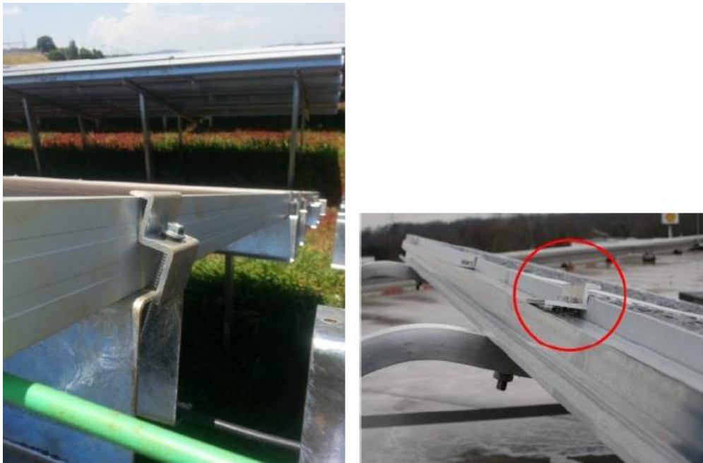
Figura 7: Posizione incorrette dei morsetti
