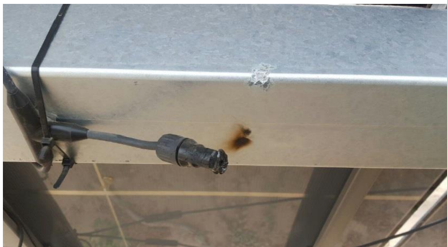
Figura 10: Esempio di guasto dovuto a connettori mal fissato [9]
