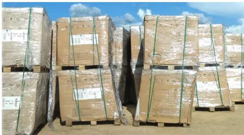
Figura 6: Stoccaggio incorretto dei moduli fotovoltaici
