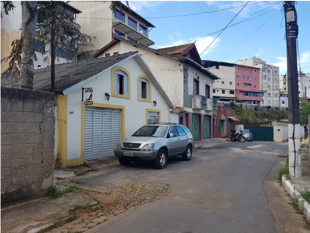
Figura 79: Vista da Rua Dimas Bezerra Dutra, com a extremidade do lote à esquerda e o fim da rua a direita, ainda é possível perceber as construções sem afastamento frontal e o uso residencial Fonte: Acervo pessoal
