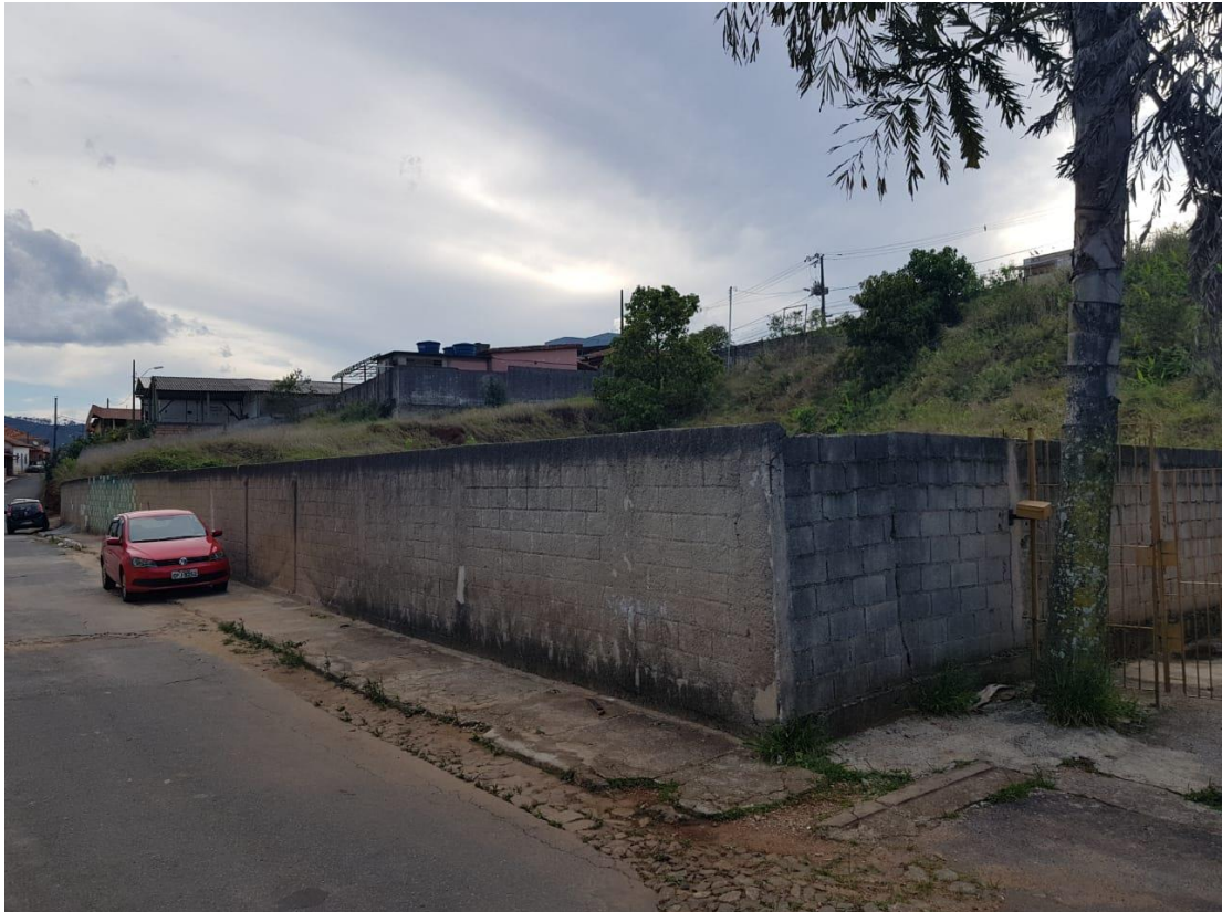
Figura 77: Vista do lote a partir da Rua Dimas Bezerra Dutra Fonte: Acervo pessoal
