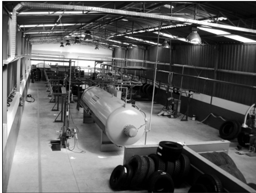
Figura 2: Visão geral da parte interna da reformadora RG Pneus
