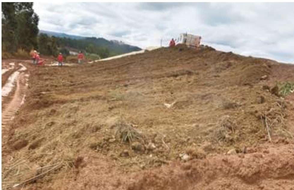
Figura 4.12. Topsoil sendo preparado para receber a hidro-semeadura.
