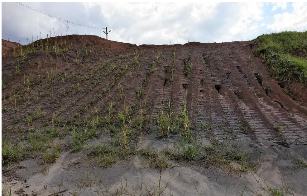
Figura 5.7. Região hidro-semeadura aplicada no rejeito da área 3.
