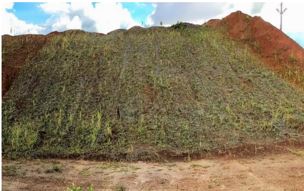
Figura 5.9. Biomanta mais hidro-semeadura da área 2.
