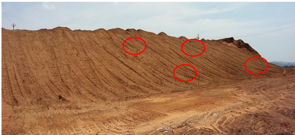
Figura 4.9. A pilha preparada e dividida com estacas, como mostra os círculos vermelhos.
