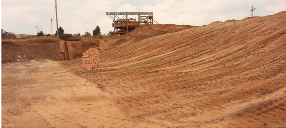
Figura 4.4. Pilha de rejeito arenoso da área 3.
