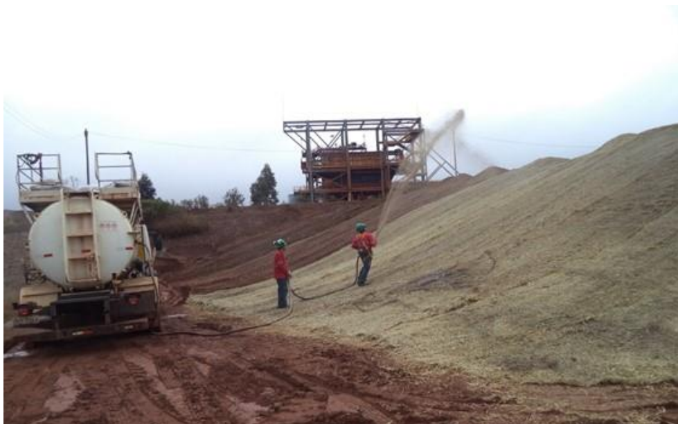
Figura 4.11. Aplicação da hidro-semeadura sobre a biomanta.
