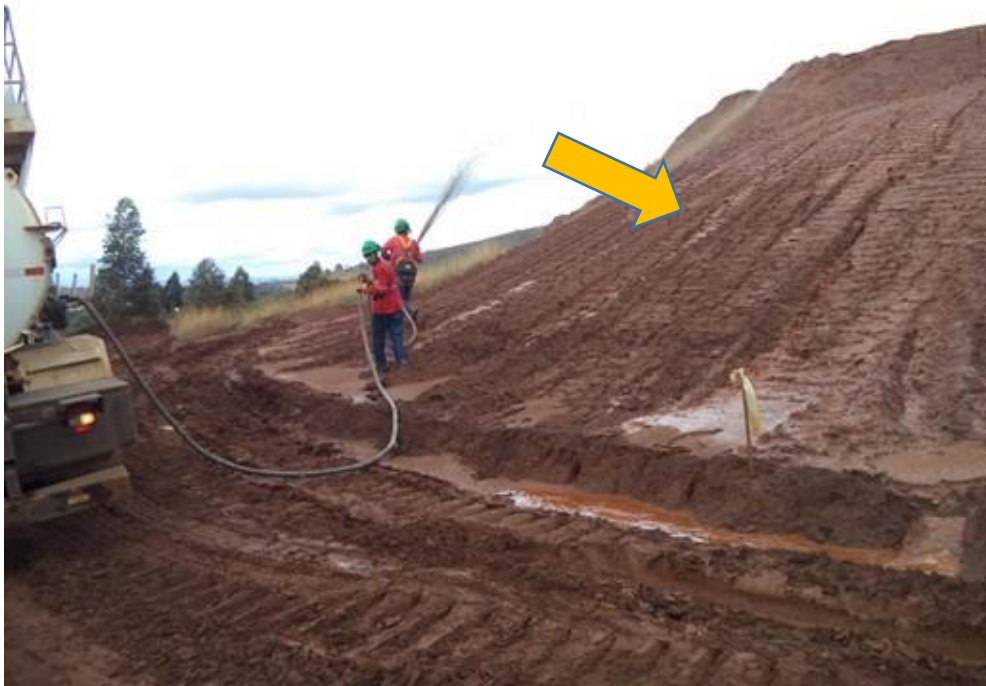
Figura 5.5. Princípio de ravinamento durante a aplicação da hidro-semeadura.
