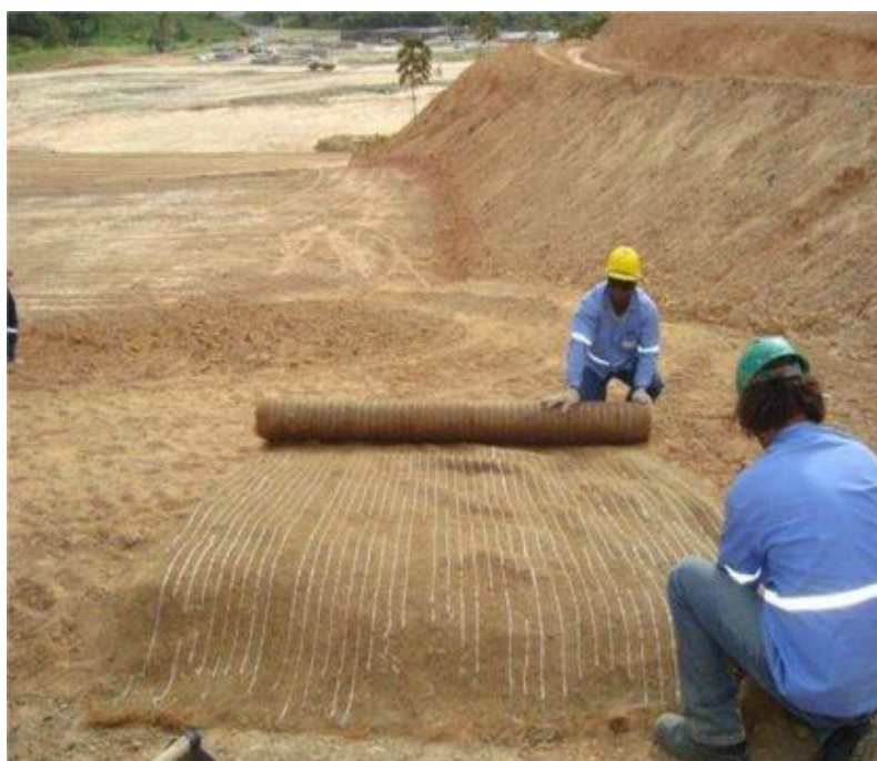
Figura 3.4. Instalação da biomanta no solo já preparado.
