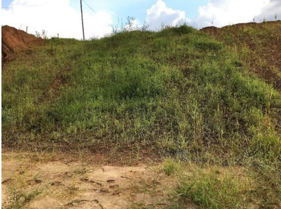
Figura 5.12. Topsoil mais hidro-semeadura da área 2.
