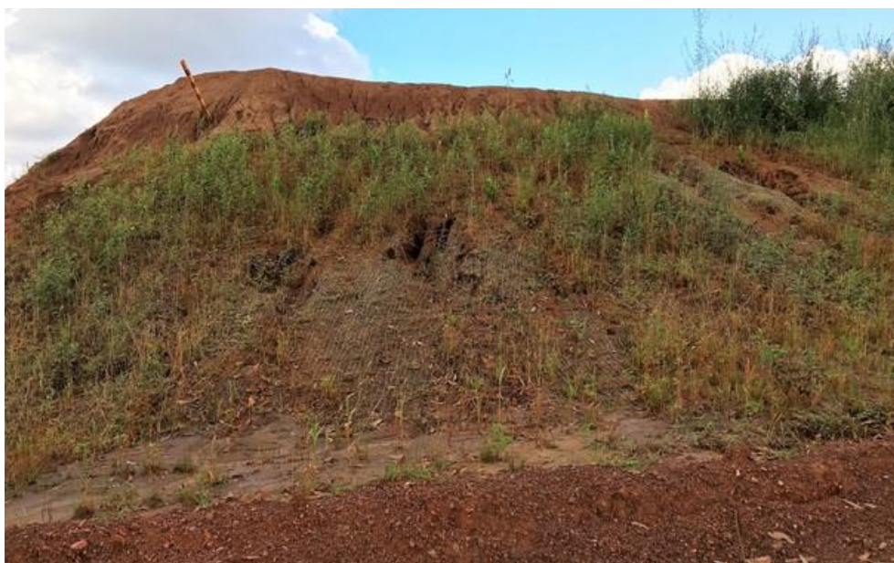
Figura 5.8. Biomanta com presença de processos erosivos da área 1.
