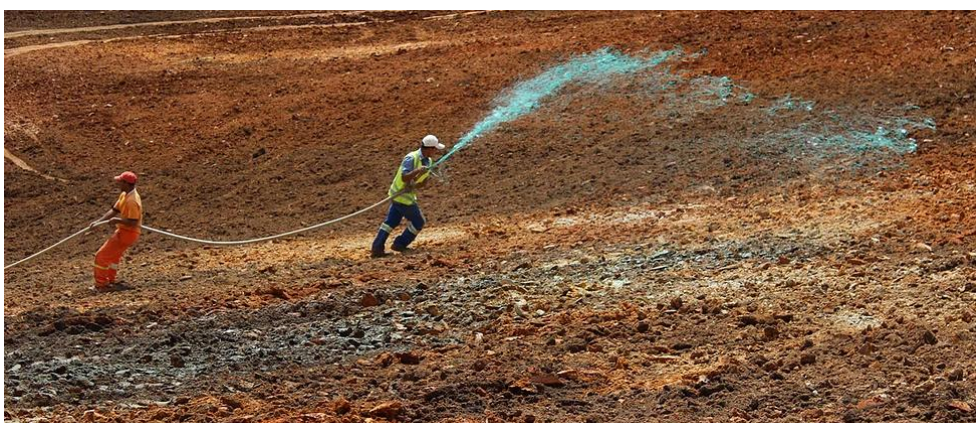
Figura 3.3. Aplicação de Hidrossemeadura.
