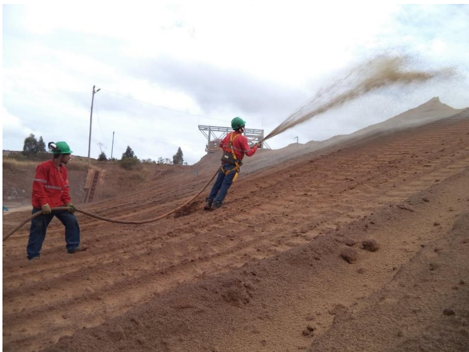
Figura 4.10. Aplicação de hidro-semeadura no rejeito.
