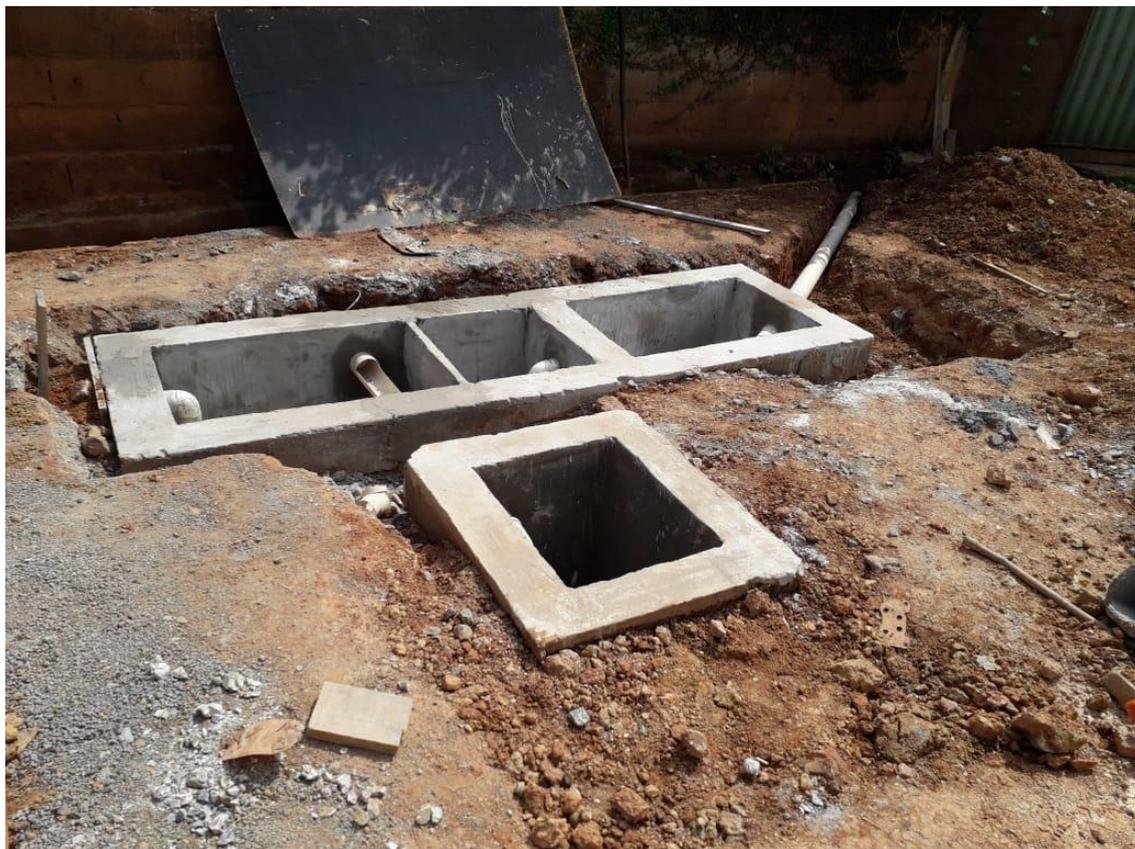
FIGURA 6.12 - Caixa separadora de água-óleo
