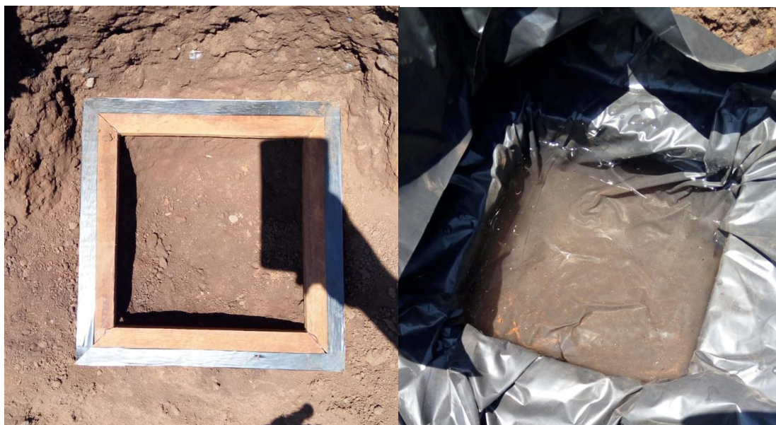
Figura 14 – Ensaio de densidade in situ
