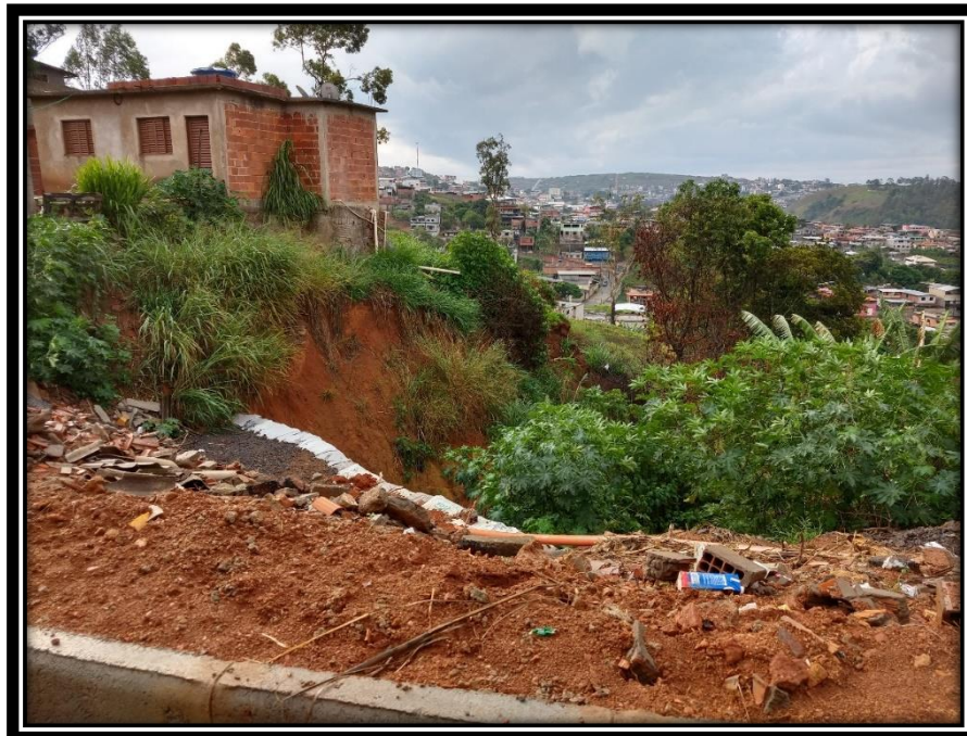
Figura 16 – Casa construída sobre encosta com entulho acumulado
