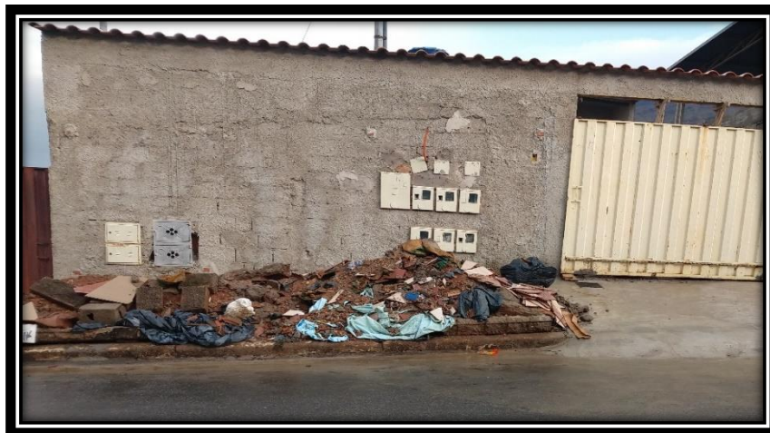
Figura 17 – Entulho e lixo acumulados sobre o passeio no bairro Cruzeiro Celeste
