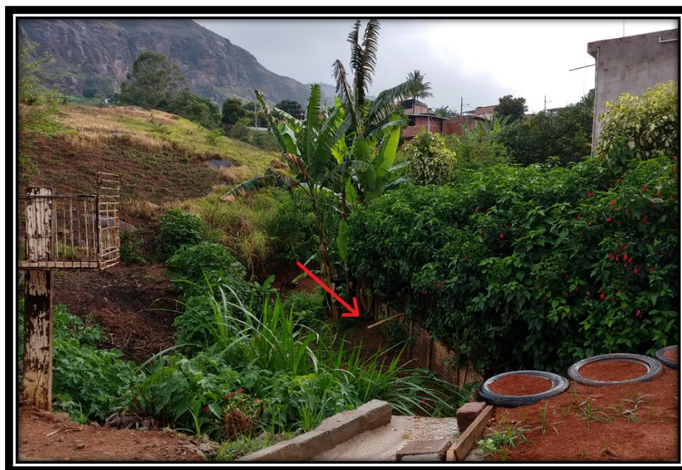
Figura 18 – Esgoto canalizado para rio no bairro Cruzeiro Celeste
