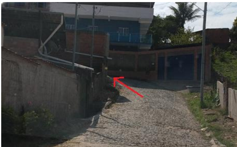
Figura 14 – Condutores horizontais direcionados à rua
