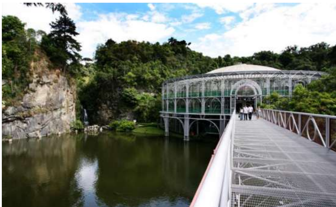
Figura 15 - Ópera de Arame, Parque das Pedreiras, Curitiba - PR.
