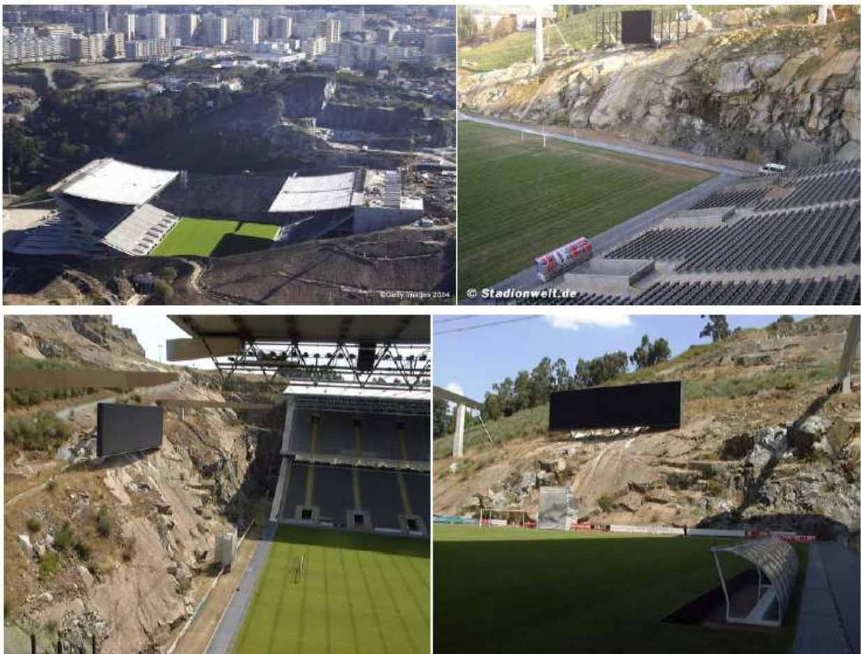
Figura 9 – Estádio de Braga concebido pelo arquiteto Eduardo Souto Moura.
