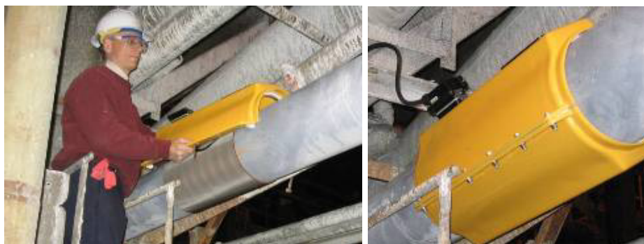
Figuras 20: Instalação da cobertura e conexões de cabos. Fonte: OLIVEIRA (2016).
