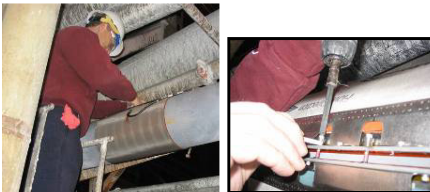
Figuras 19: Instalação do sensor. Fonte: OLIVEIRA (2016).
