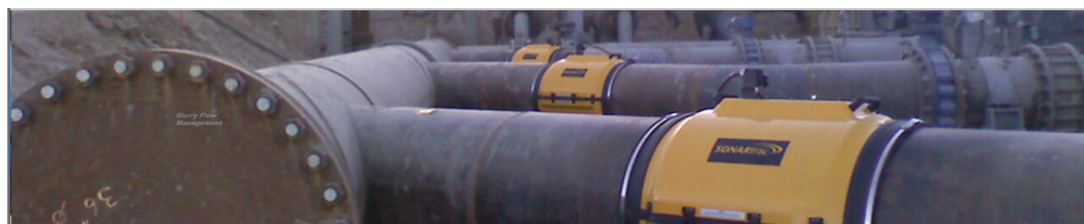
Figura 16: Medidor por sonar já instalado. Fonte: CIDRA (2016).
