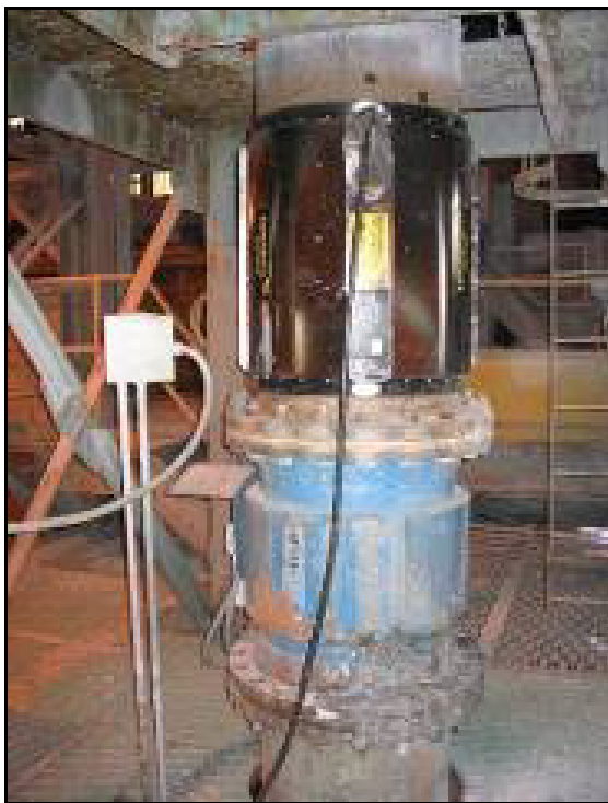
Figura 23: Medidor por sonar sem deterioração. Fonte: CIDRA (2015).
