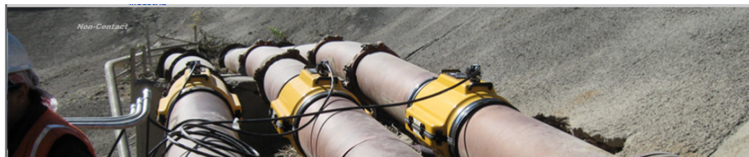
Figura 17: Medidores por sonar instalados 2. Fonte: CIDRA (2016).
