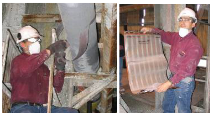
Figuras 18: Preparação da tubulação. Fonte: OLIVEIRA (2016).
