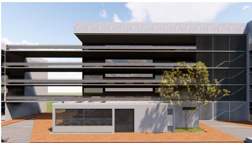
A análise das soluções técnicas utilizadas finaliza a descrição do projeto. O sistema estrutural utilizado consiste em pilares de concreto armado de 15x40cm e vigas metálicas, cujas alturas obedecem a relação de 5% do vão, e sapatas retangulares de 1.50 x 2.0 metros. O estacionamento subterrâneo e os banheiros possuem ventilação mecânica.
