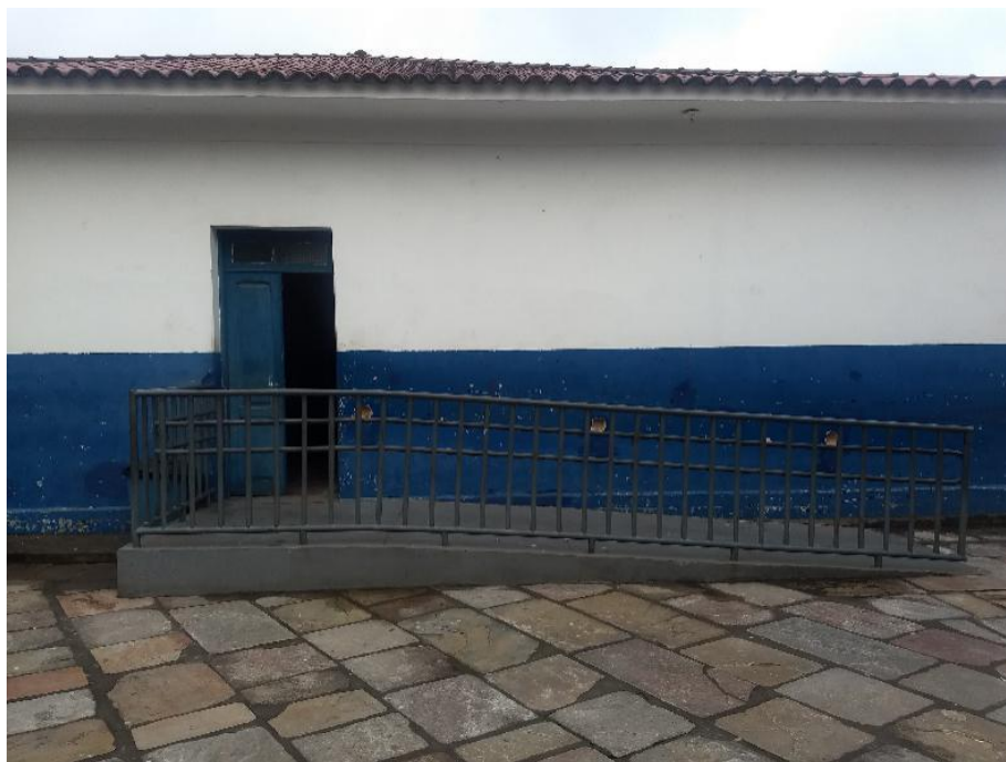
Figura 5.19: Rampa de acesso para o anexo.
