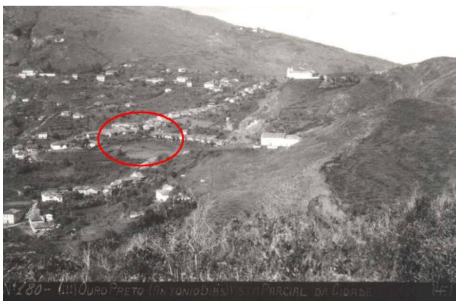
Figura 5.4: Vista da área sem a edificação anterior à escola.
