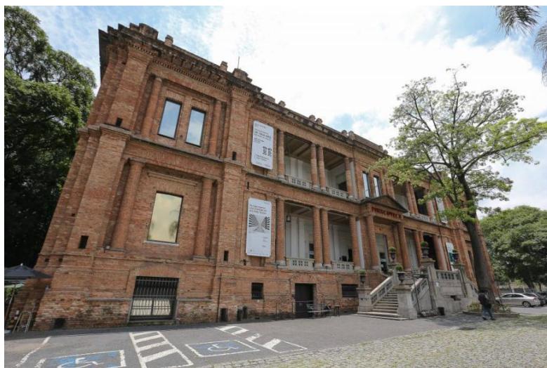
Figura 4.12: Estacionamento para PCD na Pinacoteca de São Paulo.
