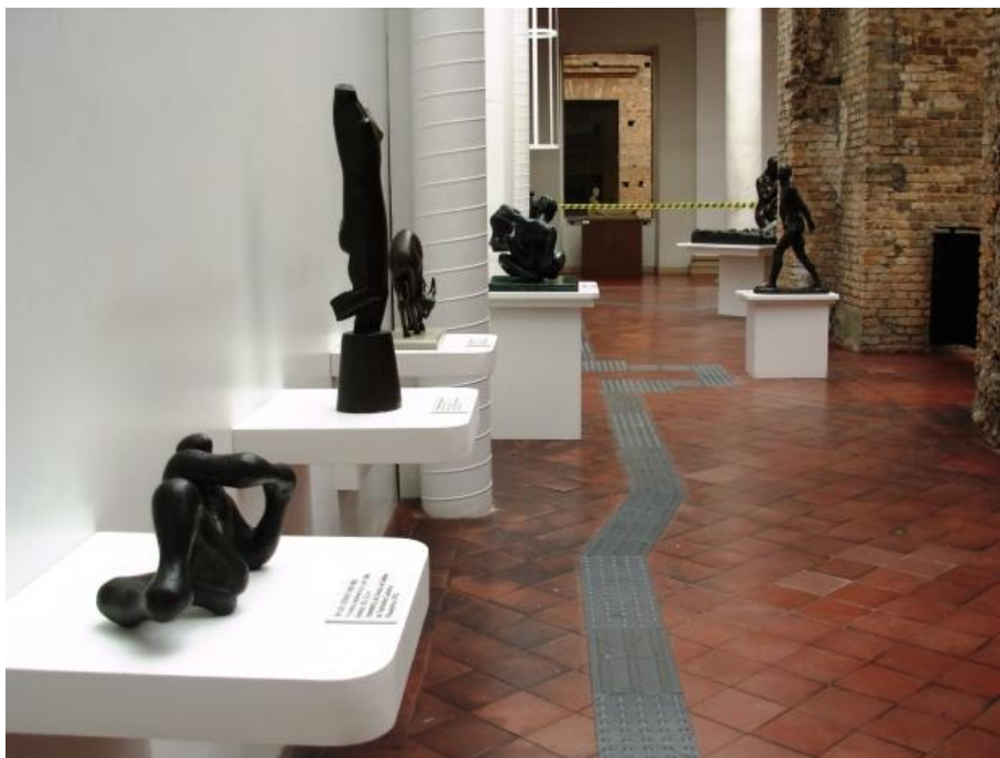
Figura 4.14: Piso Tátil na Galeria da Pinacoteca.
