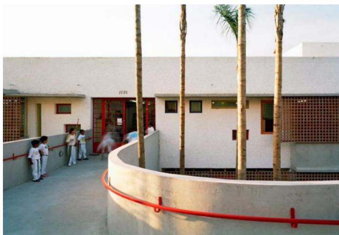
Figura 4.4: Rampa de acesso.
