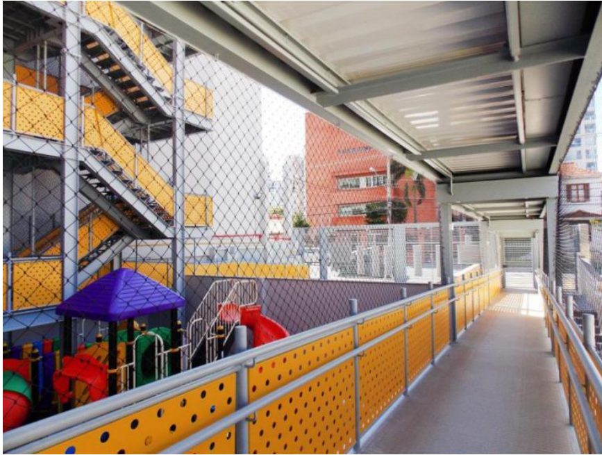
Figura 4.5: Vista da rampa.
