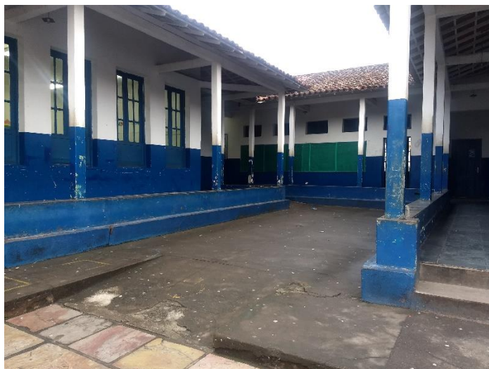
Figura 5.11: Pátio interno com destaque para a rampa de acesso.
