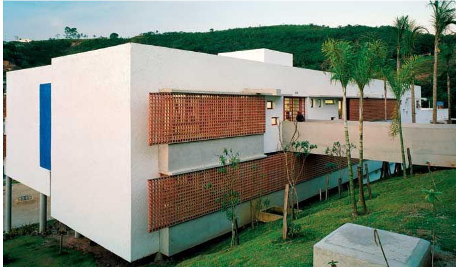
Figura 4.2: Rampa de acesso.
