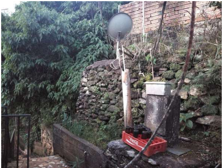
Imagem 37: Muro de pedras utilizado como parte estrutural da casa
