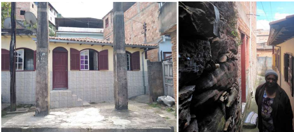
Imagem 13: Fachada frontal da residência
