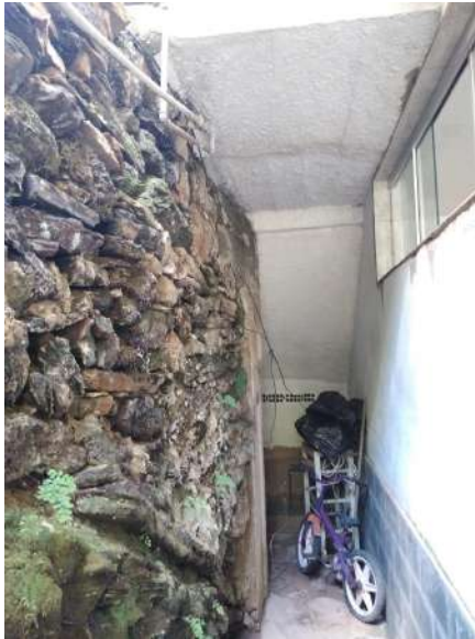
Imagem 37: Muro de pedras utilizado como parte estrutural da casa
