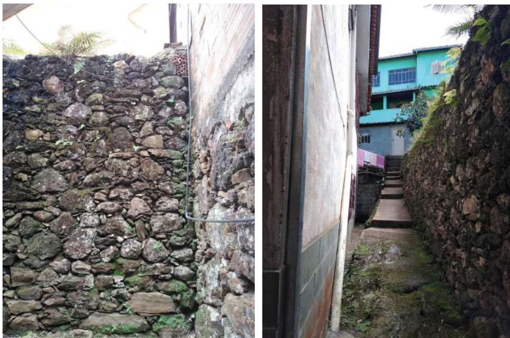
Imagem 27: Alocação das pedras nos muros
