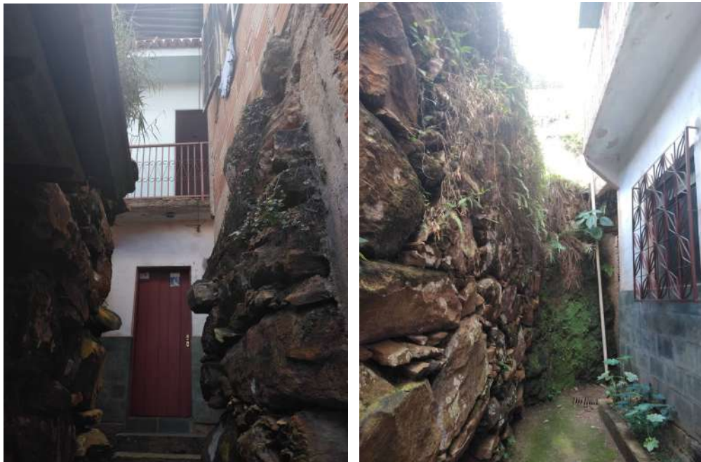
Imagem 25 e 26: Acesso para residência piso térreo
