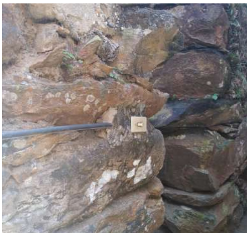
Imagem 31: Instalações elétricas presentes no mundéu
