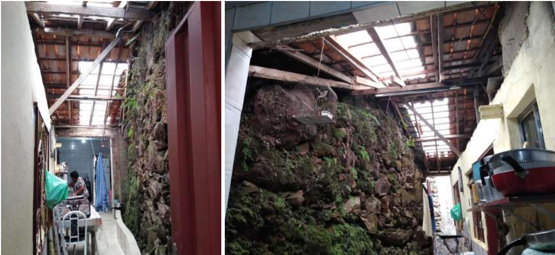
Imagem 15 e 16: Cozinha da residência, ambiente em que parte do mundéu está exposto, sendo uma das paredes estruturais.
