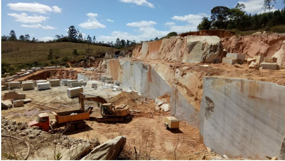
Figure 13: Frente de lavra na mina Caeté, destacando os blocos desmembrados
