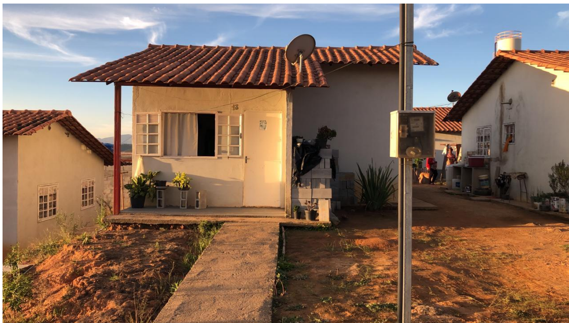
Figura 41: Fachada da casa 2
