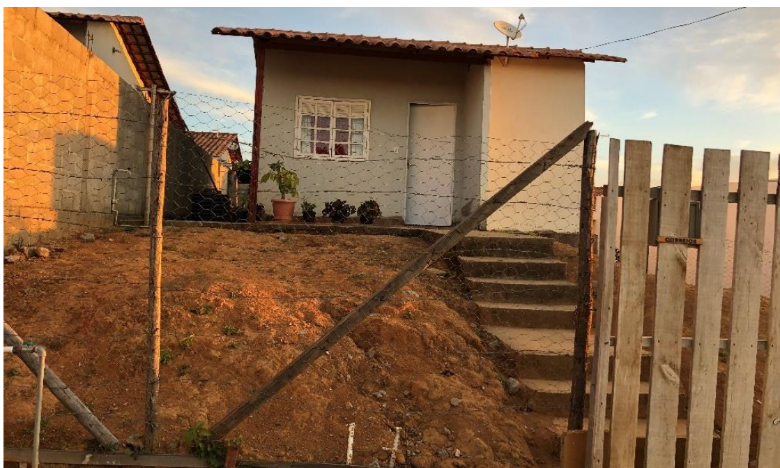
Figura 46: fachada da casa 3
