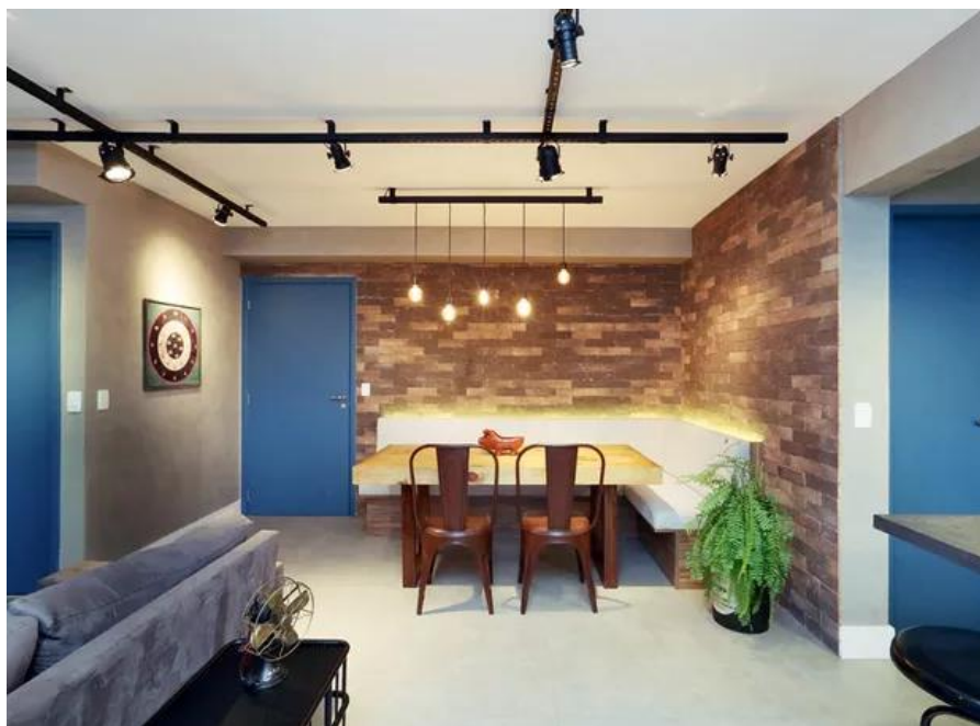
Figura 5: Exemplo de sistemas de iluminação direta e indireta atuando em conjunto
