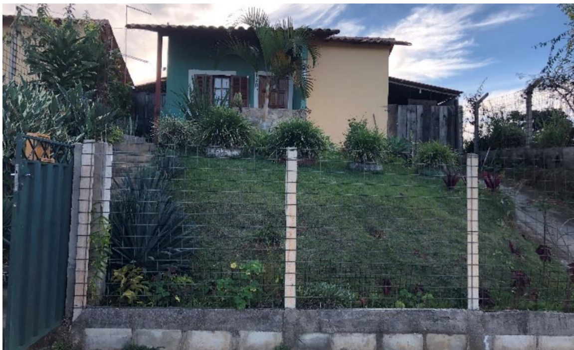
Figura 35: Fachada da casa 1
