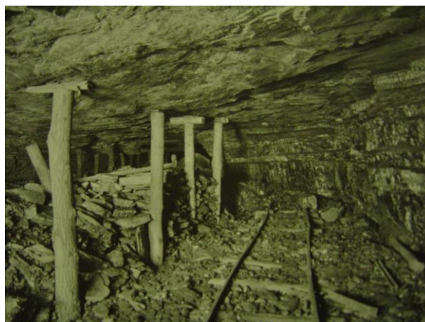
Figura 4: Esteios de madeira.
