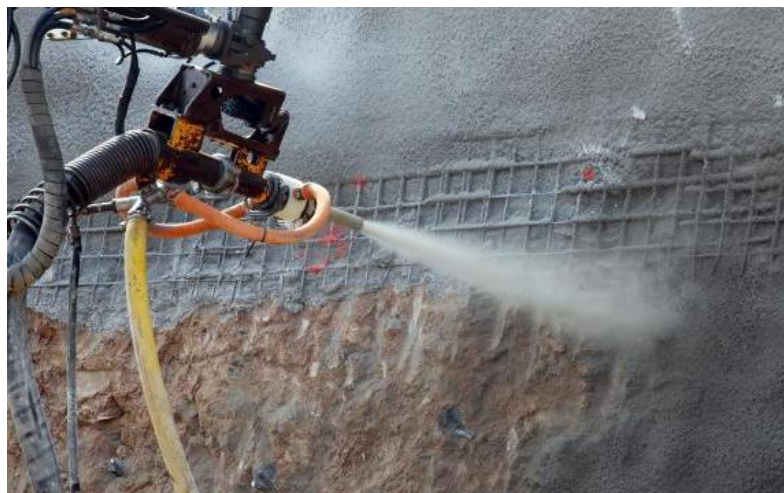
Figura 8: Aplicação de concreto projetado. Fonte: ABC Polymer, 2017.
