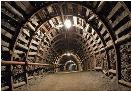
Figura 2: Exemplo de suporte compressível, o arco.
