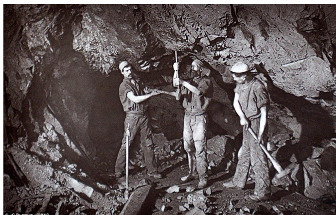
Figura 13: Instalação manual de parafuso. Fonte: MailOnline, 2014
