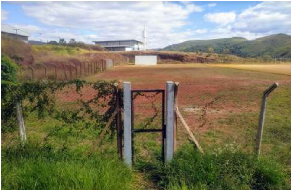
Figura 16 - Casa de Bombas do sistema de irrigação. Fonte: Autor
