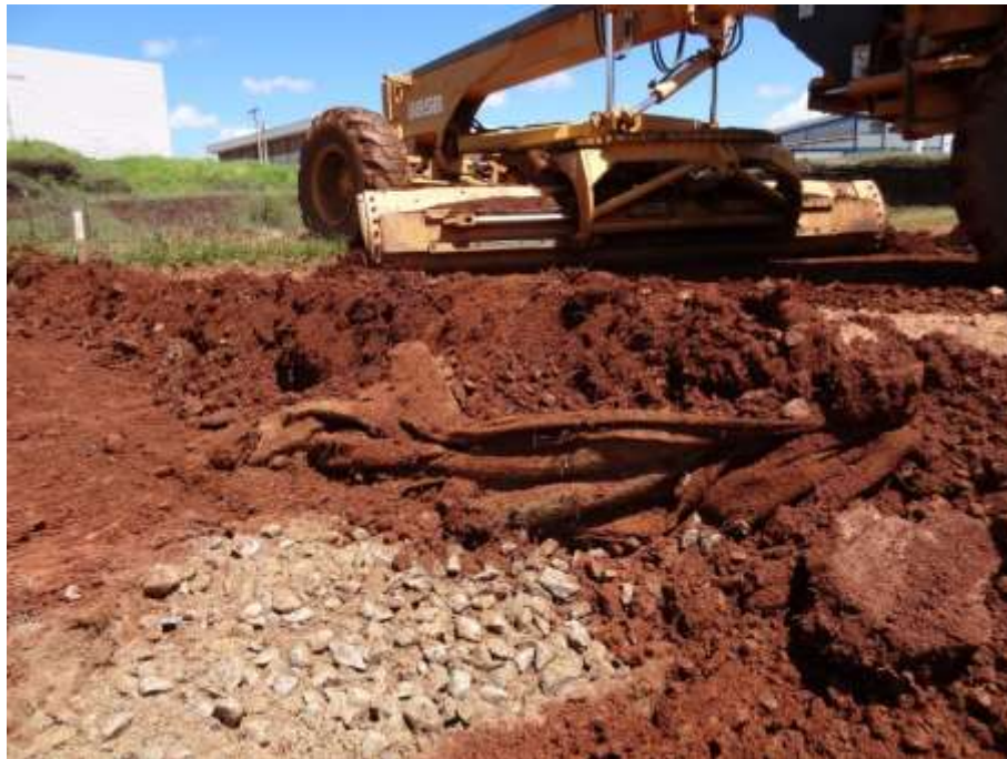
Figura 7 – Detalhe de um filtro drenante pré-existente no Campo A. Fonte: Prefeitura do Campus da IFES B
