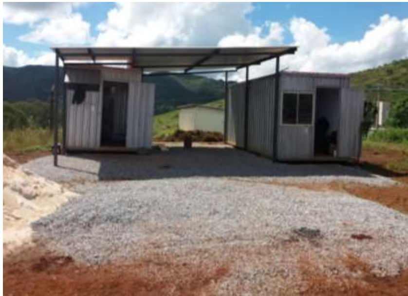
Figura 5 – Instalações provisórias para os funcionários da Empresa C. Fonte: Prefeitura do Campus da IFES B
