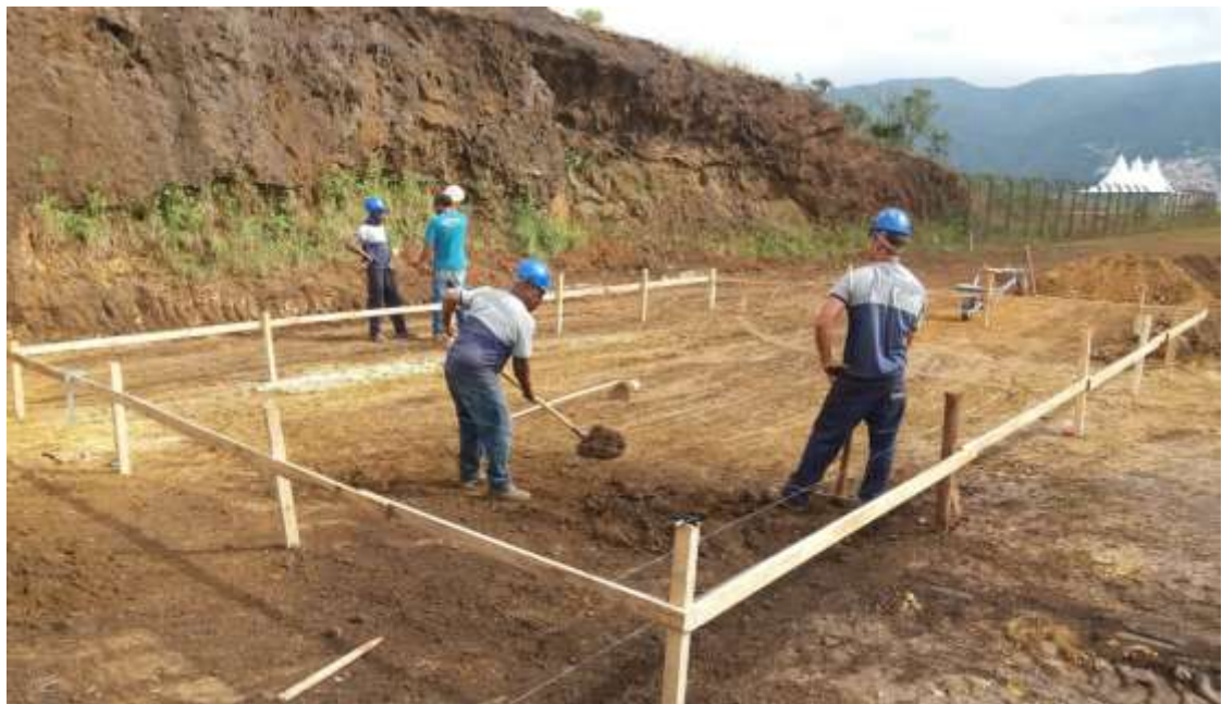
Figura 14 – Montagem do gabarito da Casa de Máquinas. Fonte: Prefeitura do Campus da IFES B
