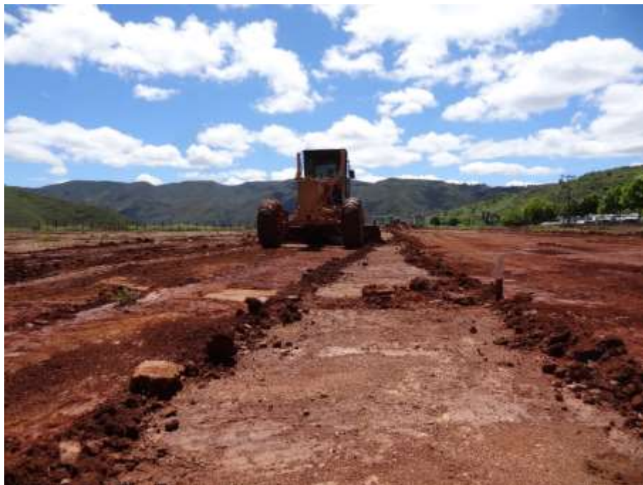
Figura 8 – Nivelamento com trator seguindo as recomendações do levantamento topográfico. Fonte: Prefeitura do Campus da IFES B
