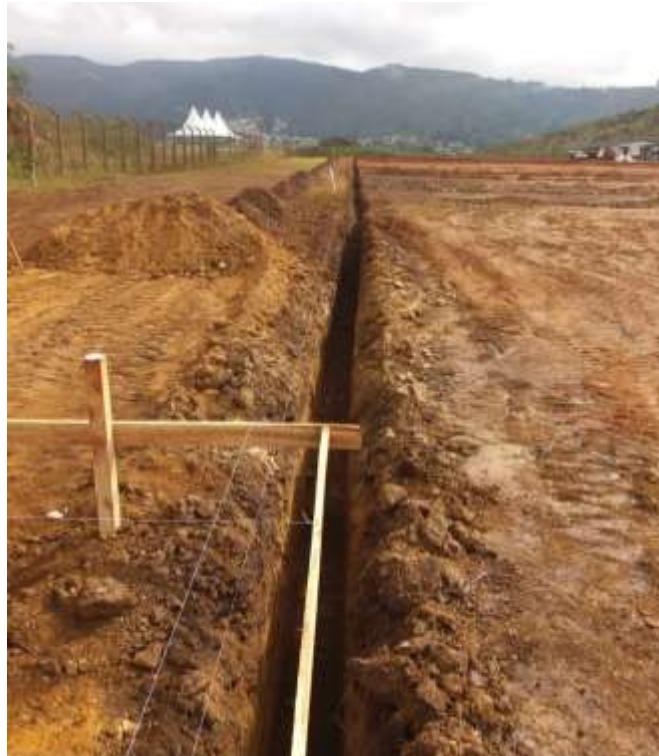
Figura 13 – Valas para a passagem do sistema de irrigação. Fonte: Prefeitura do Campus da IFES B
