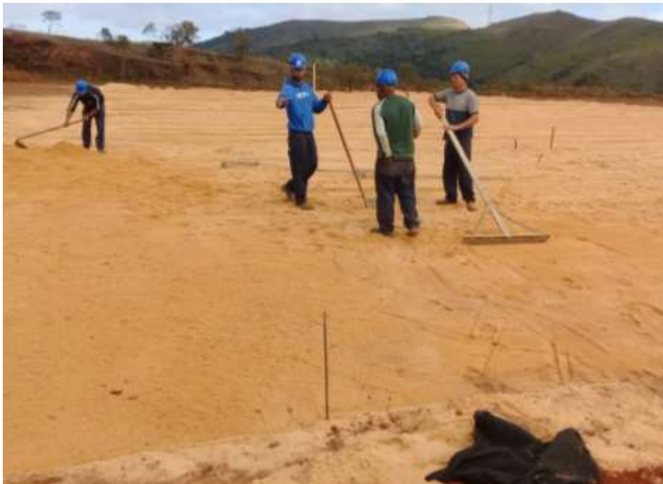
Figura 11 – Nivelamento do terreno com areia. Fonte: Prefeitura do Campus da IFES B
