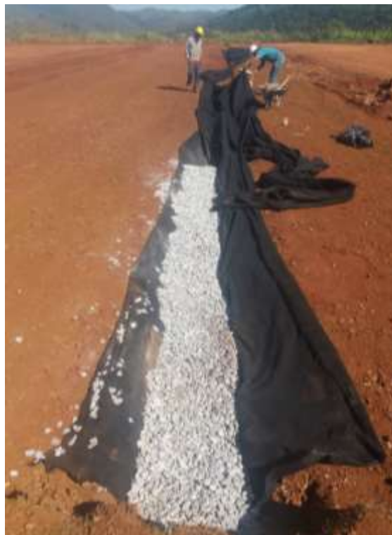
Figura 10 – Instalação do filtro drenante. Fonte: Prefeitura do Campus da IFES B
