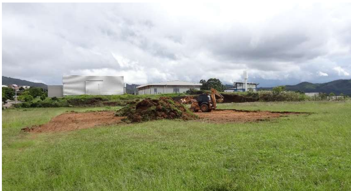
Figura 6 – Remoção da camada superficial de solo para nivelamento de acordo com projeto topográfico. Fonte: Prefeitura do Campus da IFES B
