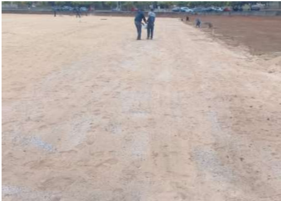
Figura 29 – Aplicação incorreta do TerraCottem® sobre o solo. Fonte: Prefeitura do Campus da IFES B
