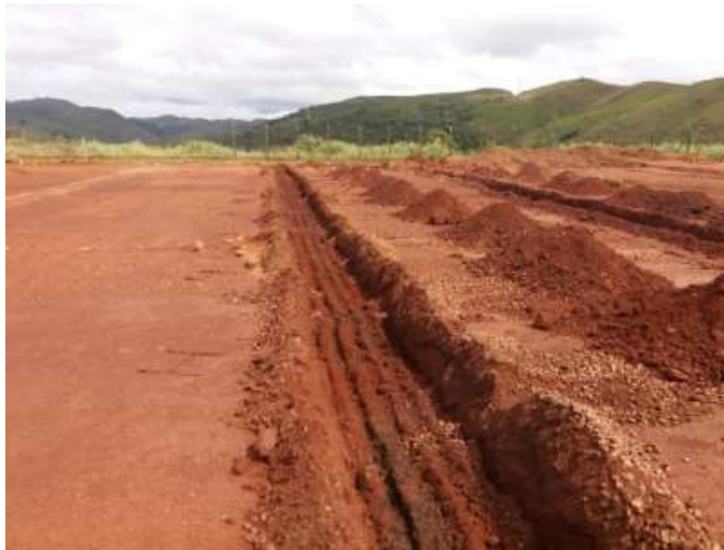
Figura 9 – Valas para execução do filtro drenante. Fonte: Prefeitura do Campus da IFES B
