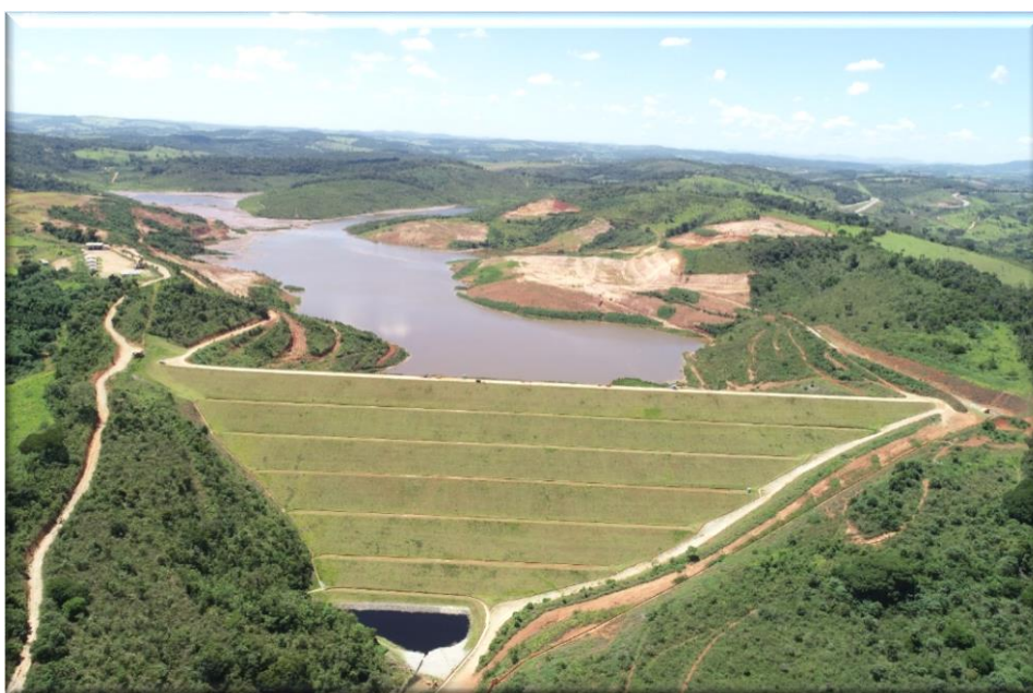
Figura 15 – Vista superior Barragem 7
