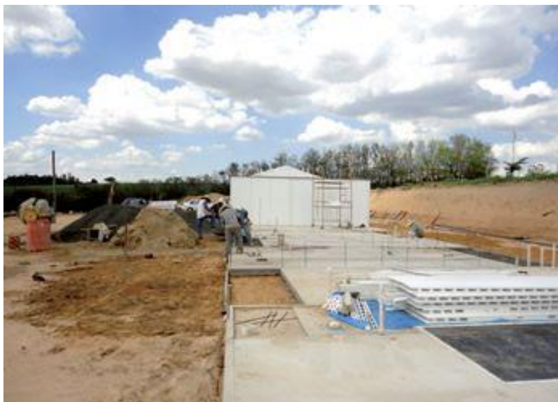
Figura 4 - Radier executado para o sistema em concreto - PVC. (MANDEL, 2013).
