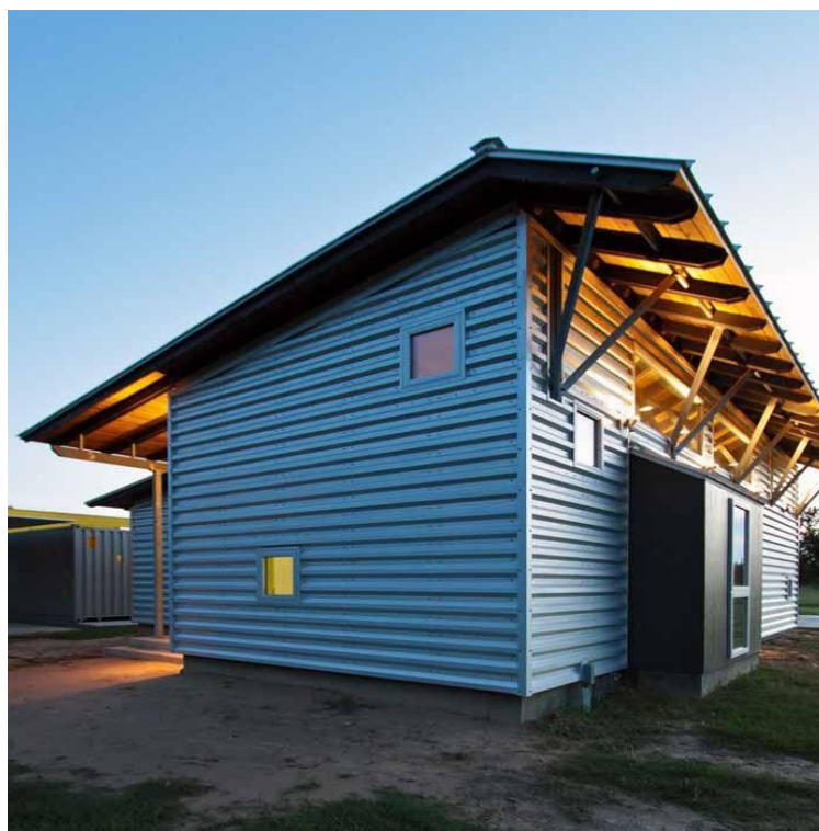
Figura 10 – Casa popular construída com sistema estrutural baseado em containers (DECORFÁCIL, 2019).
