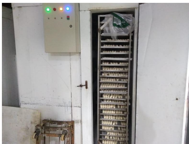
Figura 13: Interior da câmara de congelamento. Fonte: Pesquisa direta (2019).
