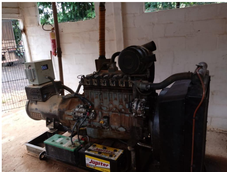
Figura 17: Motogerador da propriedade
