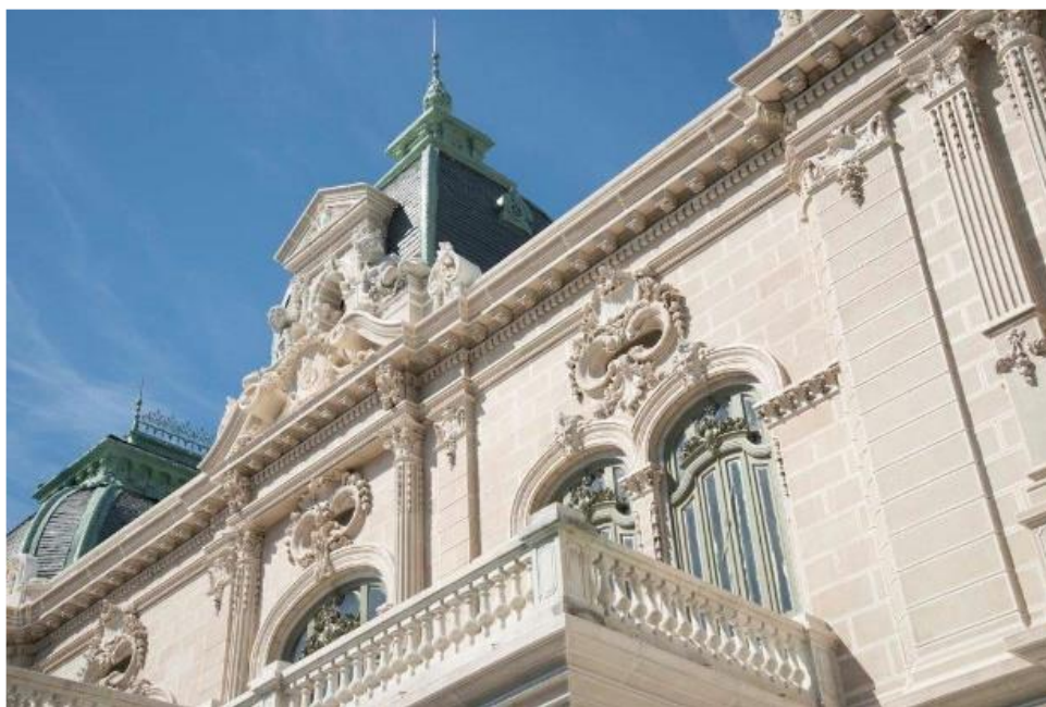
Figura 26 – Detalhes da fachada lateral do Palácio das Laranjeiras. Fonte: (LIMA, 2016).
