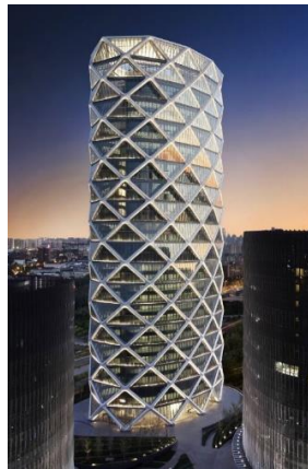
Figura 1.1- North Glass Building construído com pilares mistos circulares preenchidos com concreto. ( North Glass , 2017).
