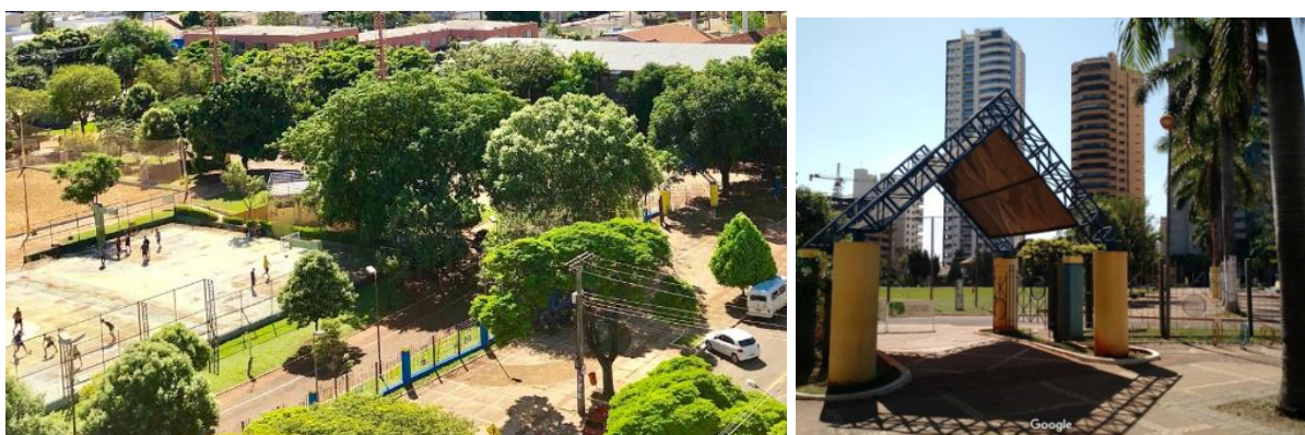
Imagens 38 e 39 – Vista aérea e visa da entrada da Praça Belmar Fidalgo cercada por gradil metálico
