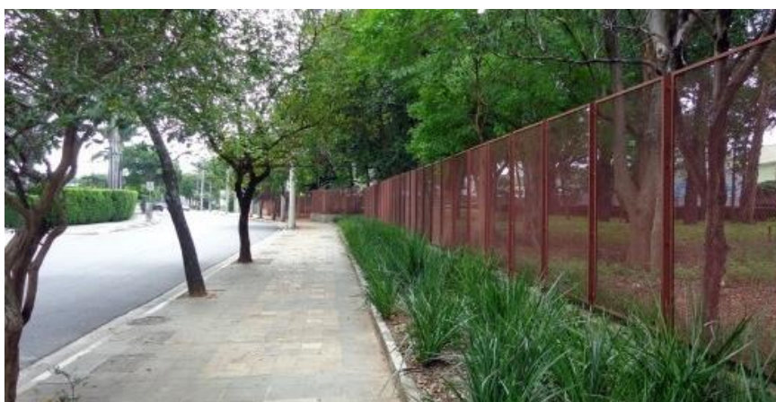
Imagem 34 –Gradil metálico da fachada da Praça Victor Civita.
