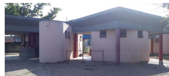
3 - b) Banheiros e depósito de materiais
