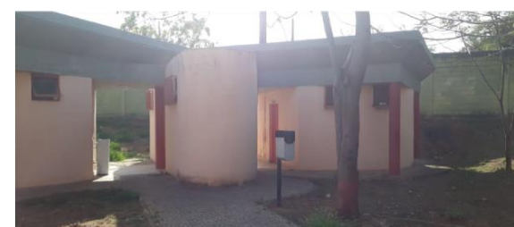
4- b) Banheiros e depósito de materiais
