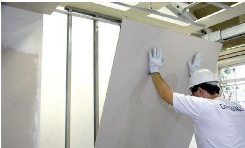
Figura 12 – Colocação da chapa Drywall.
