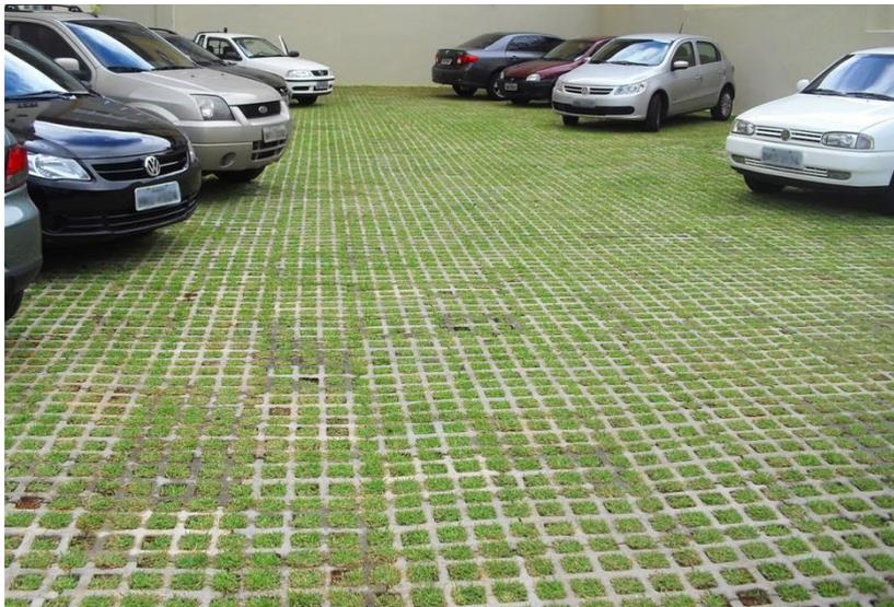
**Figura 11 – Pavimento permeável do tipo blocos vazado (Assembleia Legislativa do Estado de São Paulo, 2012).**
