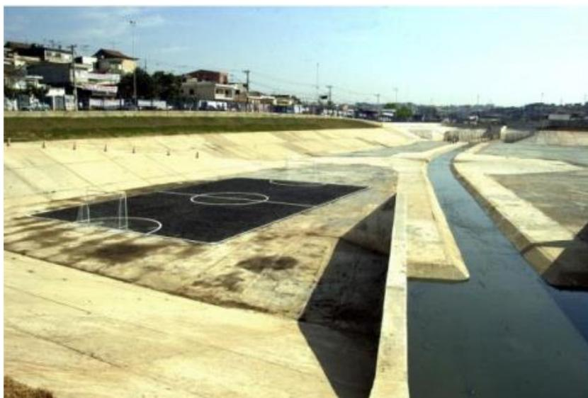
**Figura 7 – Reservatório de retenção seco em Tamanduateí – SP (CANHOLI, 2015).**
