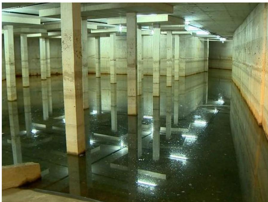
**Figura 8 – Reservatório de detenção fechado em Vitória – ES (G1, 2015).**
