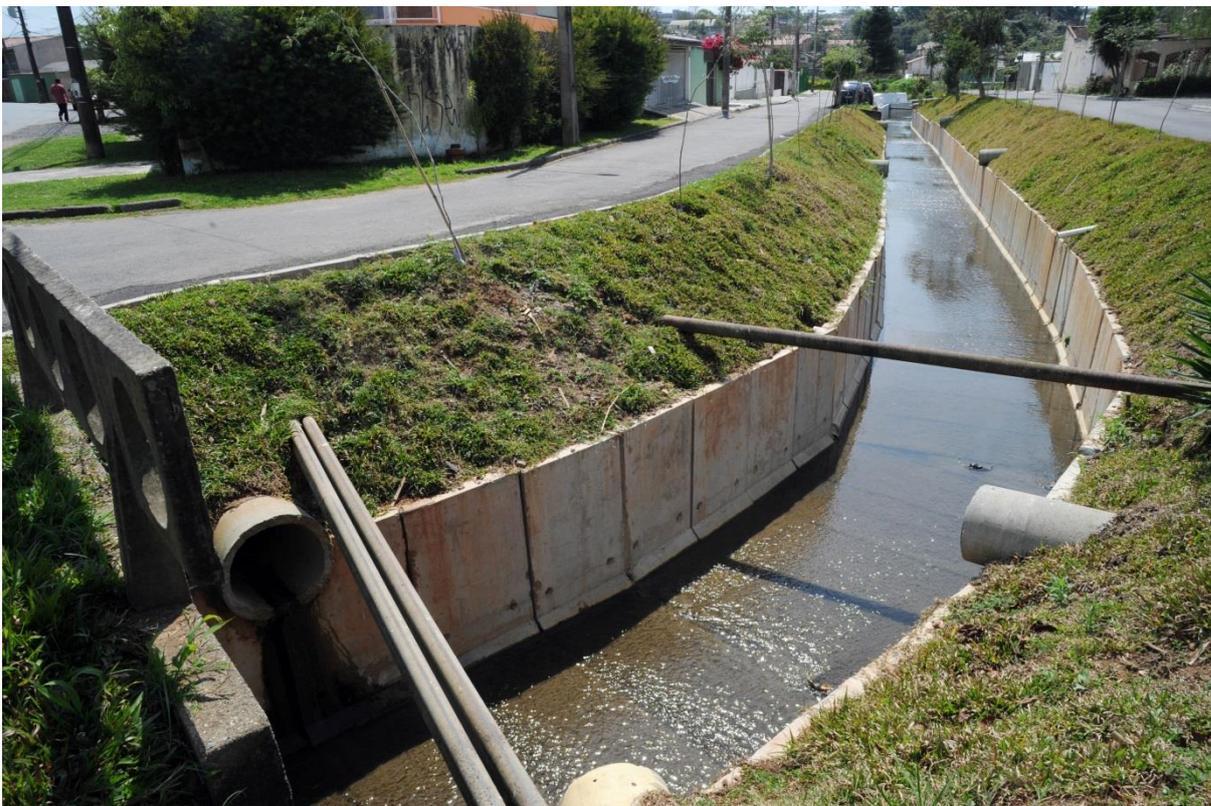
**Figura 5 – Canalização do córrego Estribo Ahú em Curitiba – PR (PPC, 2016).**
