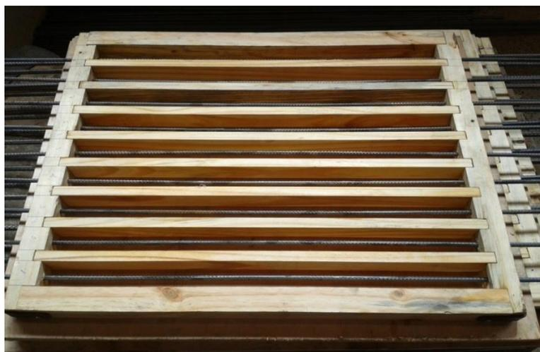
Figura 4.2: Forma utilizada na concretagem dos tirantes.
