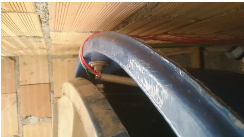
Figura 41: Saída dos Cabos do Sensor de Nível
