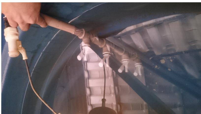
Figura 40: Sensor de Nível Instalado
